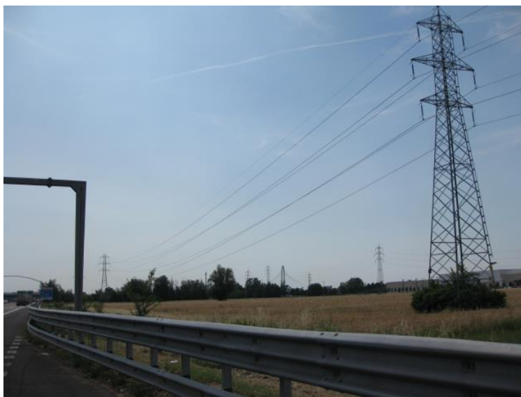
Foto 27 - Dall'Autostrada A1 verso l'elettrodotto in demolizione
