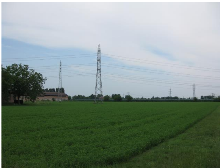
Foto 41 - Nei pressi della Stazione elettrica di Rubiera
