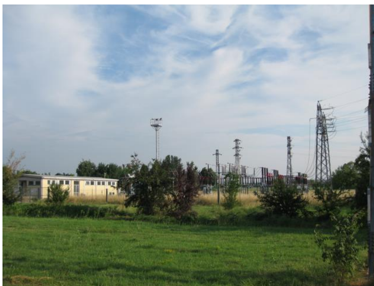
Foto 14 - Stazione elettrica di Castelnovo di Sotto
