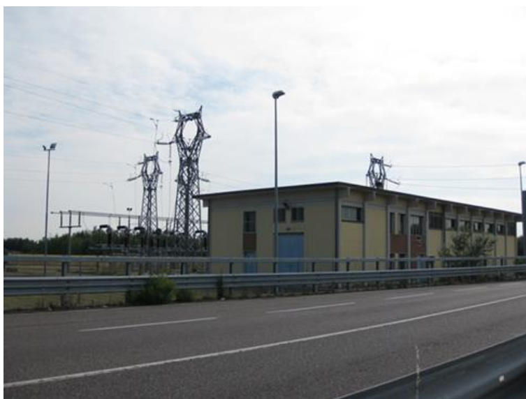
Foto 1 – Cabina primaria di Boretto
