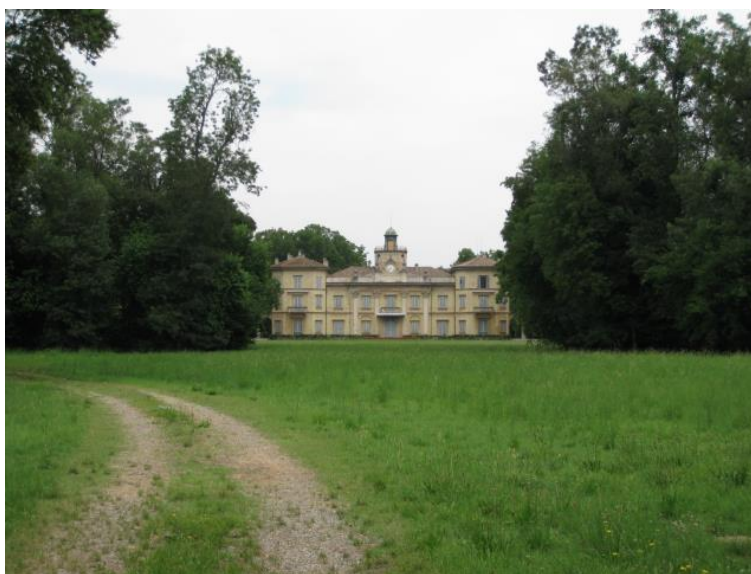
Foto 30 - Facciata principale di Villa Spalletti
