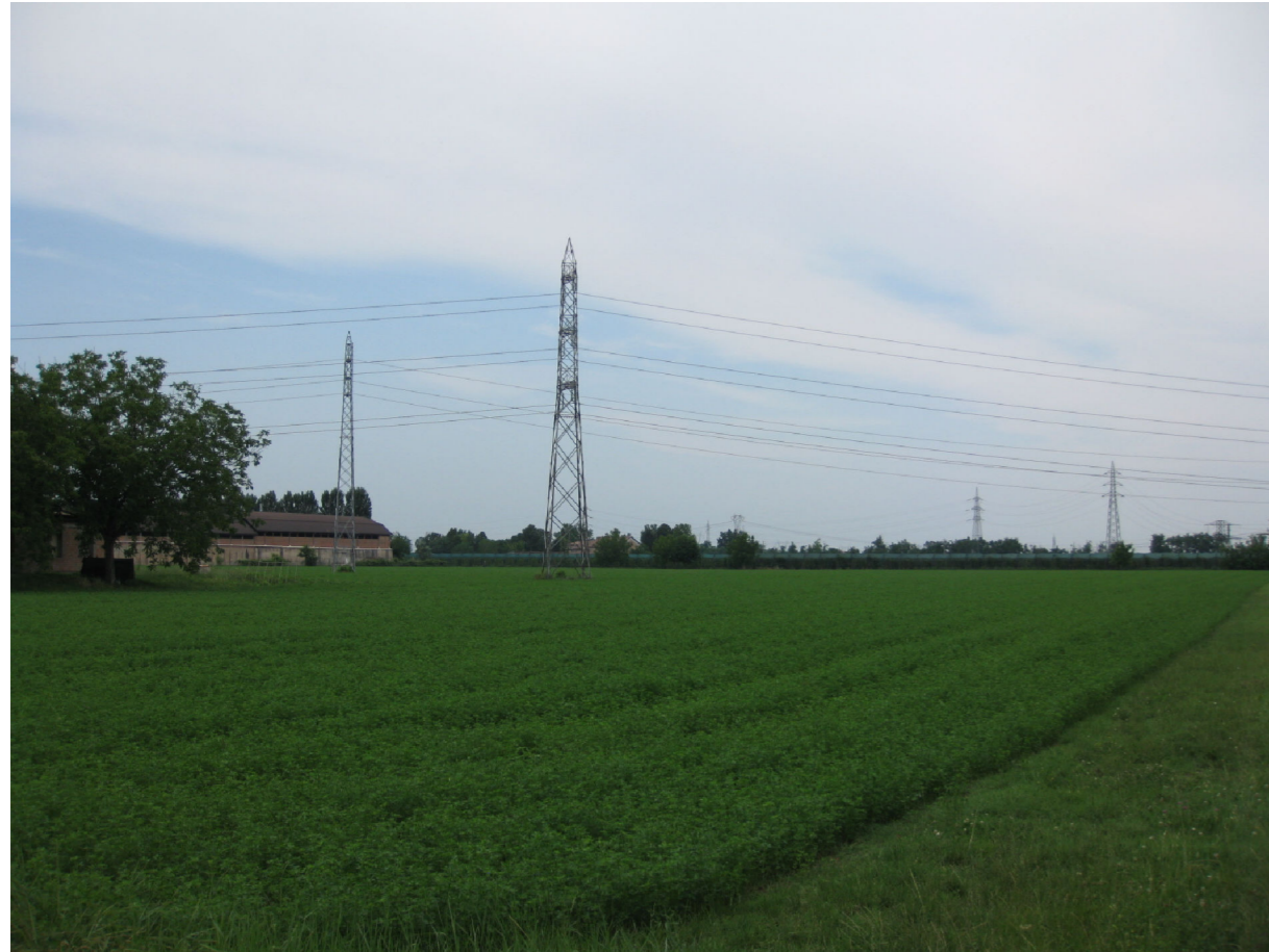
Punto di vista 12: da Via Case Secchia, in prossimità della SE Rubiera - Stato di fatto
