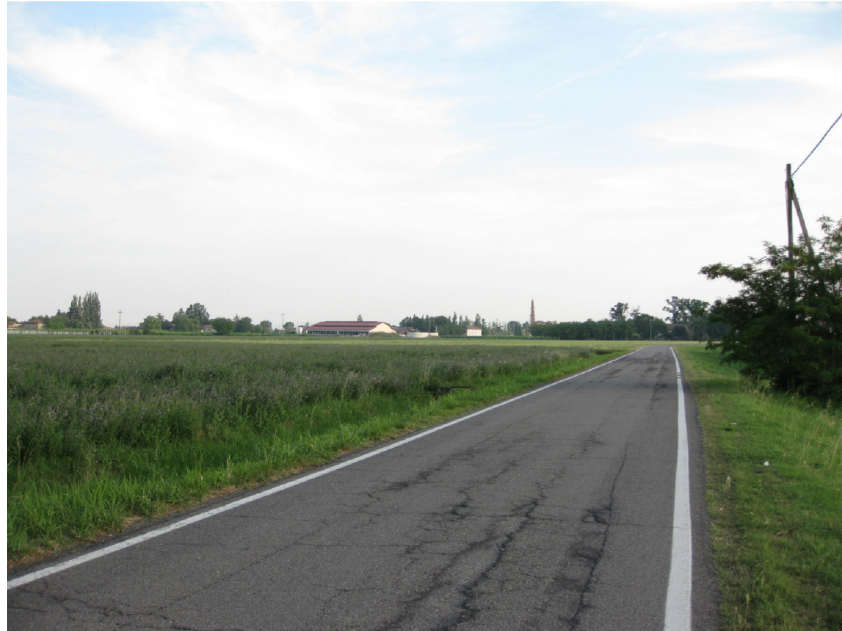
Punto di vista 7: da Via Ferri, in prossimità dell'abitato di Castello di Vialato - Stato di fatto
