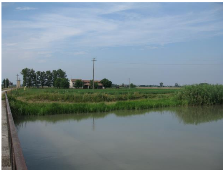
Foto 12 - Canale derivatore a Nord-Est di Terramara di Santa Rosa
