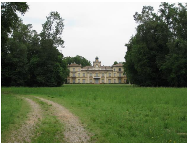
Foto 30 - Facciata principale di Villa Spalletti
