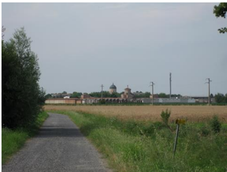
Foto 4 – Abitato di Boretto dalla Cabina Primaria
