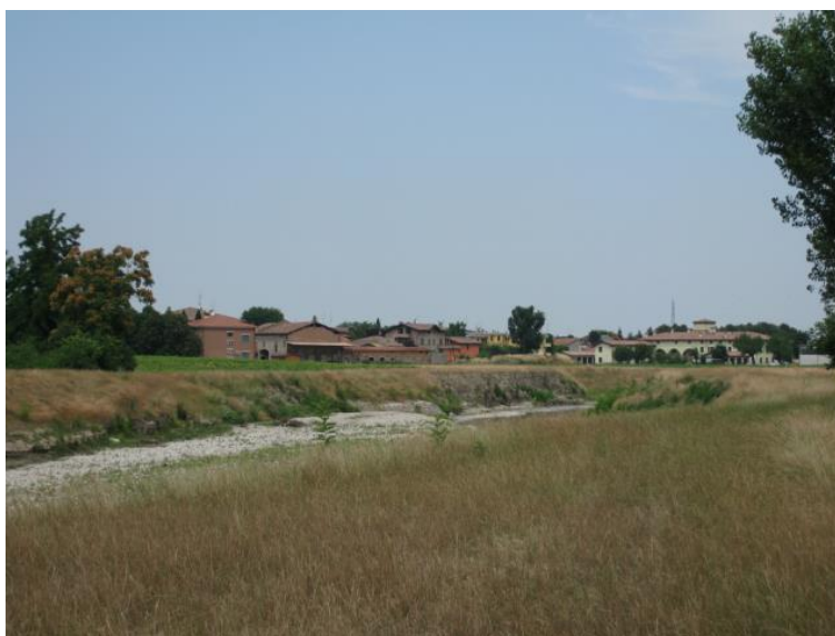
Foto 38 - Torrente Tresinaro dal ponte nei pressi di Due Maestà
