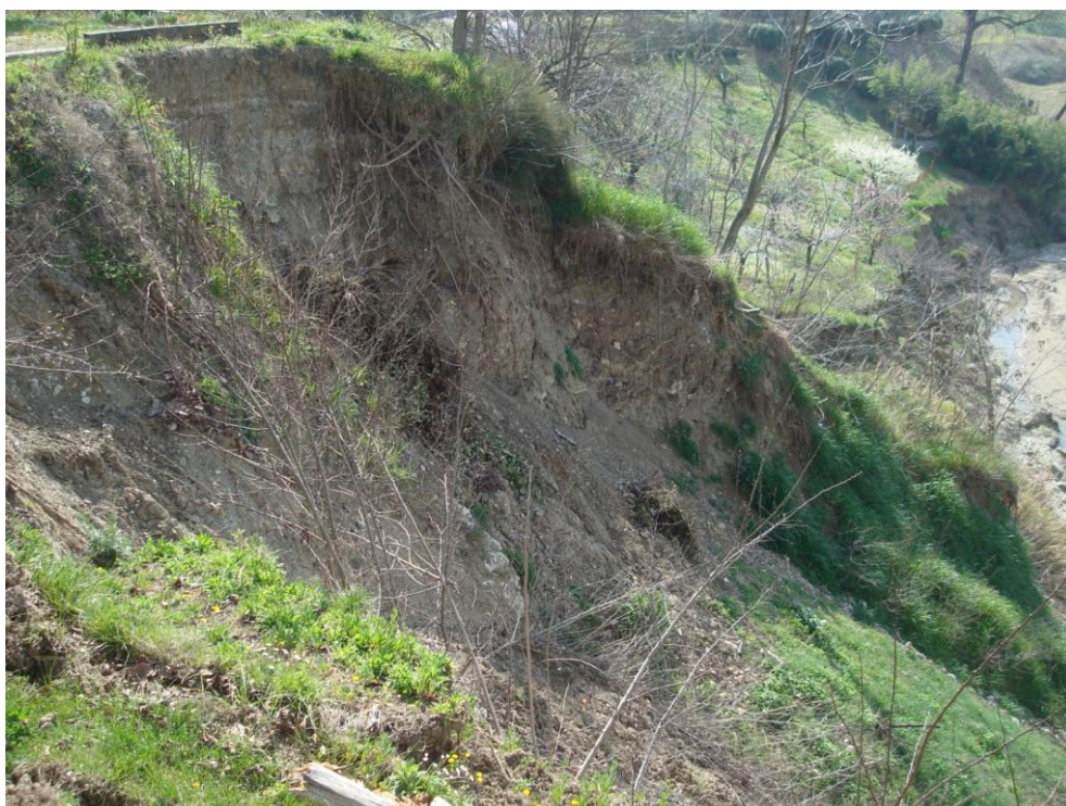
Foto 2- Coronamento del dissesto. In secondo piano sulla destra si evidenzia il letto del Fiume Marecchia e l'erosione di sponda che caratterizza il tratto anche a monte del dissesto.
