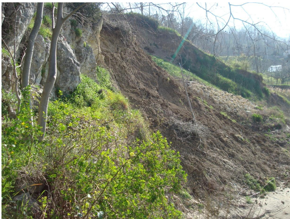
Foto 1- piede del dissesto al contatto con il letto del Fume Marecchia. In primo piano sulla sinistra in alto massi dello sperone calcareo..
