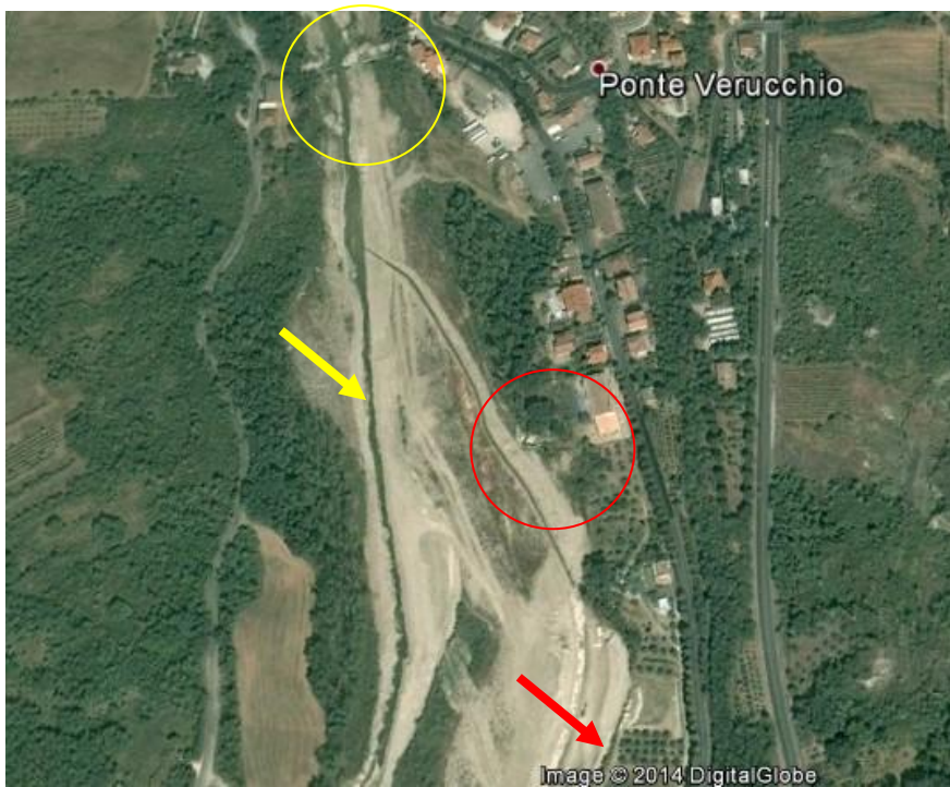
Fig. 3 - Fotogramma da google Earth anno 2008 -mese Agosto. In rosso si evidenzia l'area in cui attualmente si è verificato il dissesto. In giallo si evidenzia l'esistenza della briglia rotta. In evidenza la presenza della massciata (freccia rossa) e della savanella (freccia gialla)
