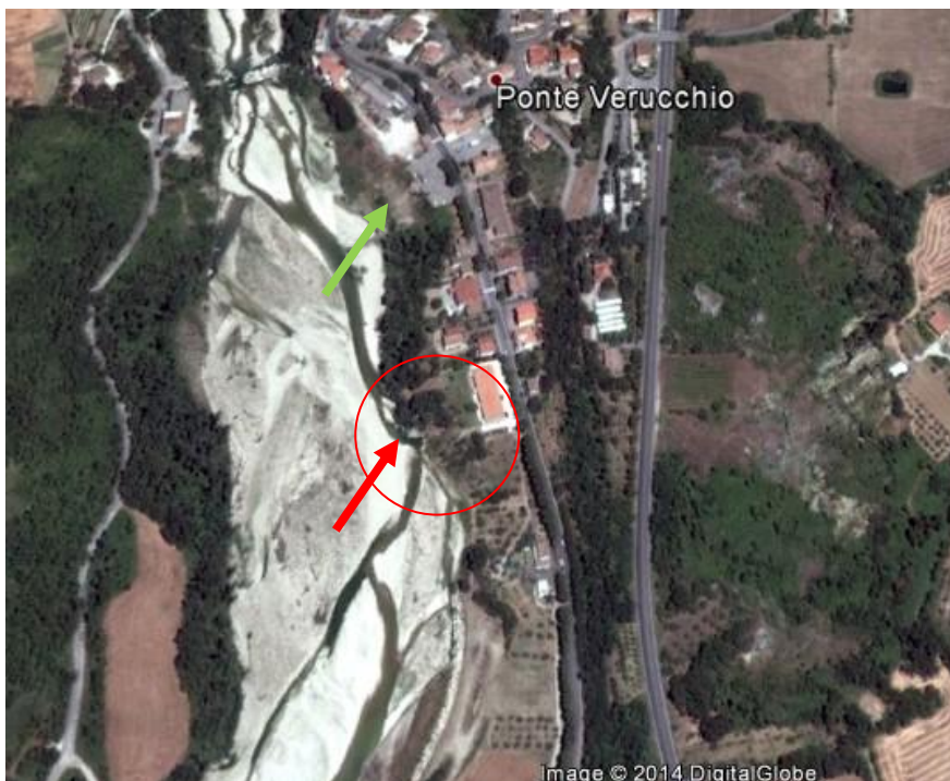
Fig. 4 - Fotogramma da google Earth anno 2012 -. In rosso si evidenzia l'area in cui attualmente si è verificato il dissesto. La freccia rossa indica la posizione dei massi calcarei e la zona in cui si è formato il gorgo. La freccia verde indica l'area parcheggio "Zaganti".
