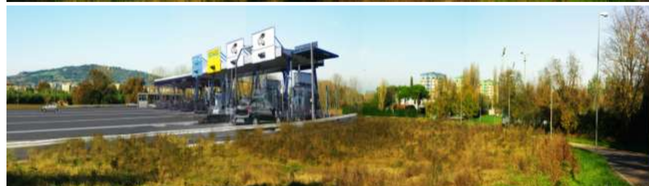
Prima e Dopo: Casello Stazione Pesaro Sud
