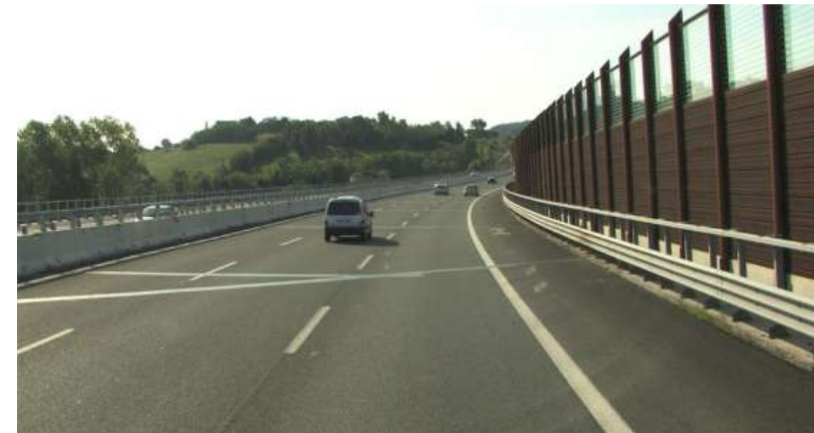
La A14 direzione nord (sopra) e sud (sotto) con l'ampliamento della Terza Corsia
