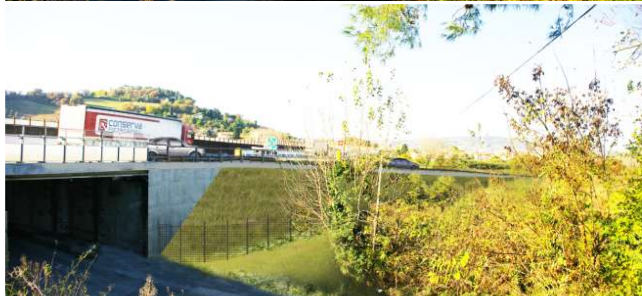
Prima e Dopo: Sottovia e Rampa di uscita in direzione Nord.
