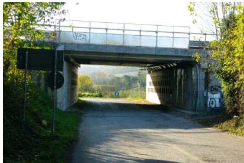
L'esistente sottopasso autostradale interessato dall'ampliamento per la realizzazione delle rampe
