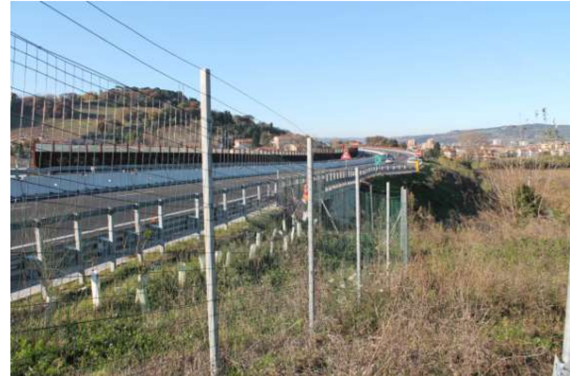
L'esistente tratto autostradale interessato dalle nuove rampe di collegamento al Casello Pesaro Sud
