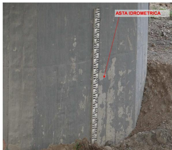
Figura 2.1. Asta idrometrica del Mignone al ponte della SS1
