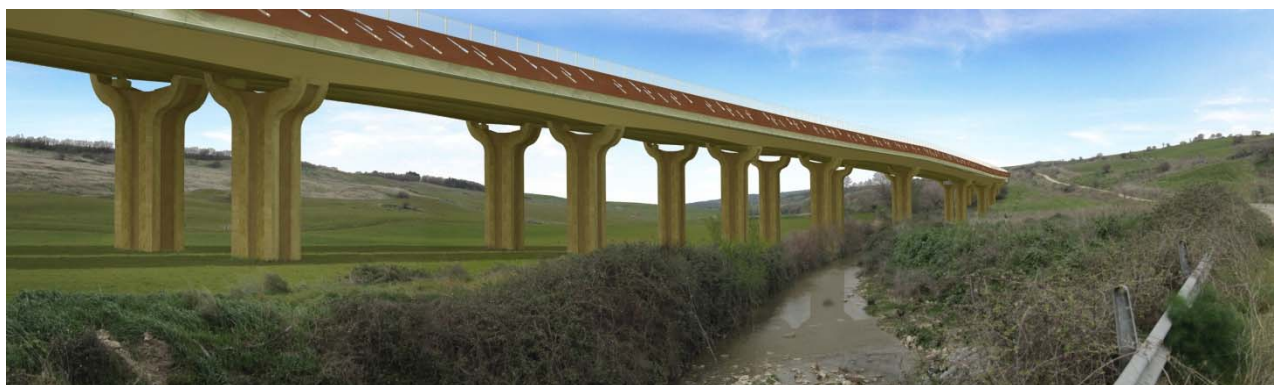
Inserimento nel paesaggio del viadotto Nasso con i RAL 7008 e 8000 ed i profili in acciaio corten
