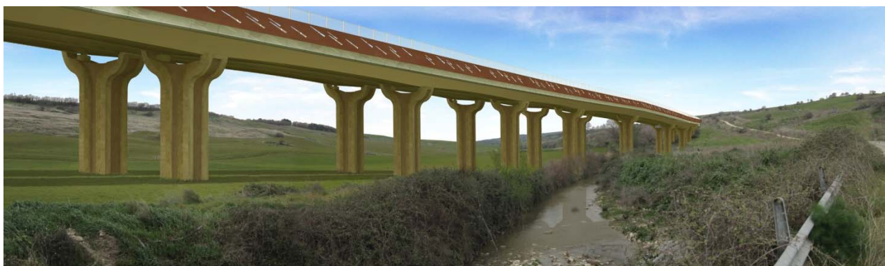
Inserimento nel paesaggio del viadotto Nasso con i RAL 7008 e 8000 ed i profili in acciaio corten
