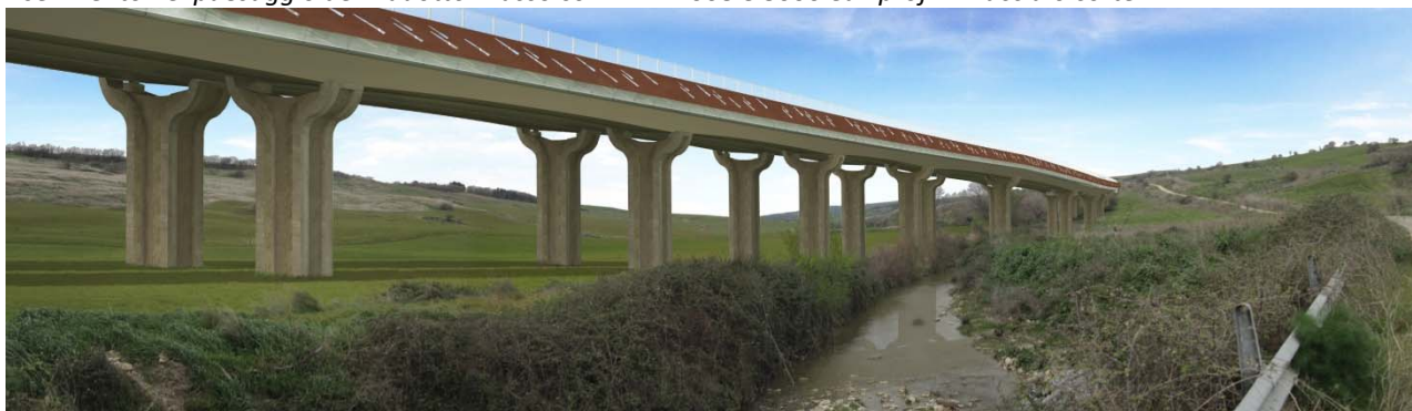
Inserimento nel paesaggio del viadotto Nasso con i RAL 7034 e 7006 ed i profili in acciaio corten
