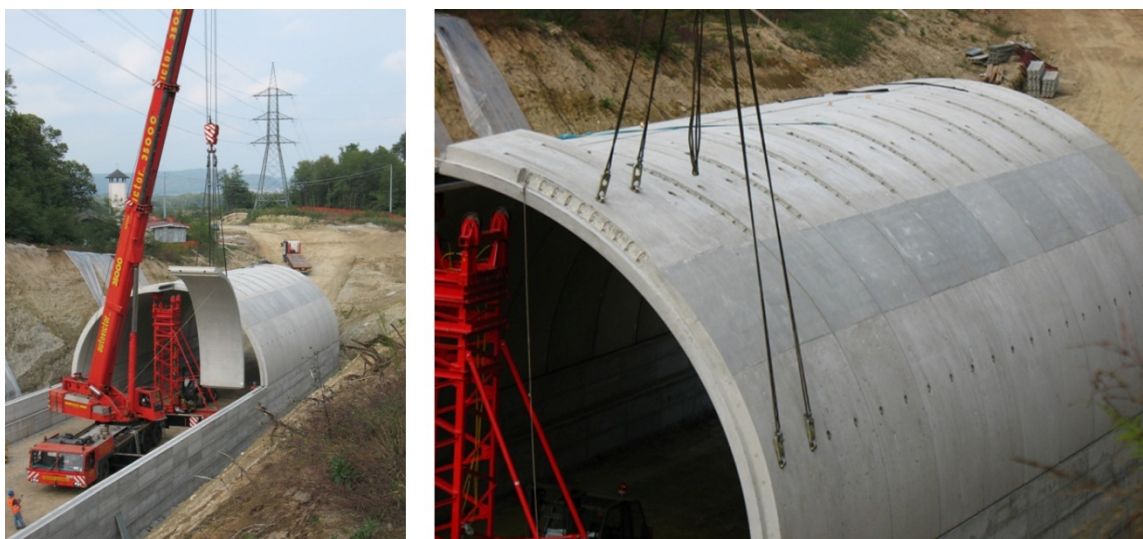
Fase di montaggio dei conci prefabbricati
