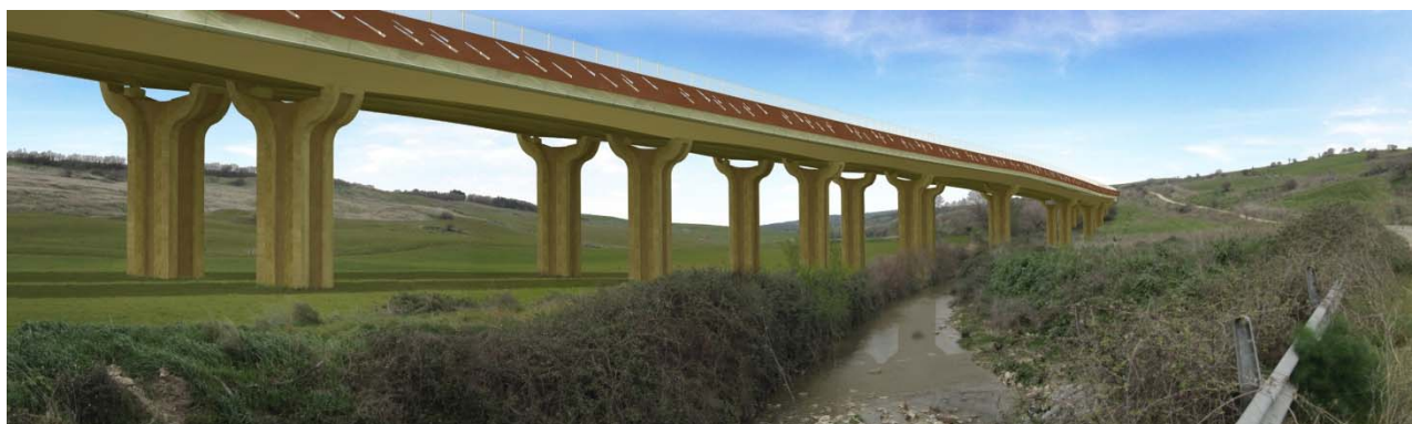
Inserimento nel paesaggio del viadotto Nasso con i RAL 7008 e 8000 ed i profili in acciaio corten
