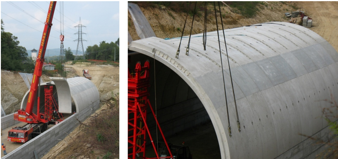
Fase di montaggio dei conci prefabbricati
