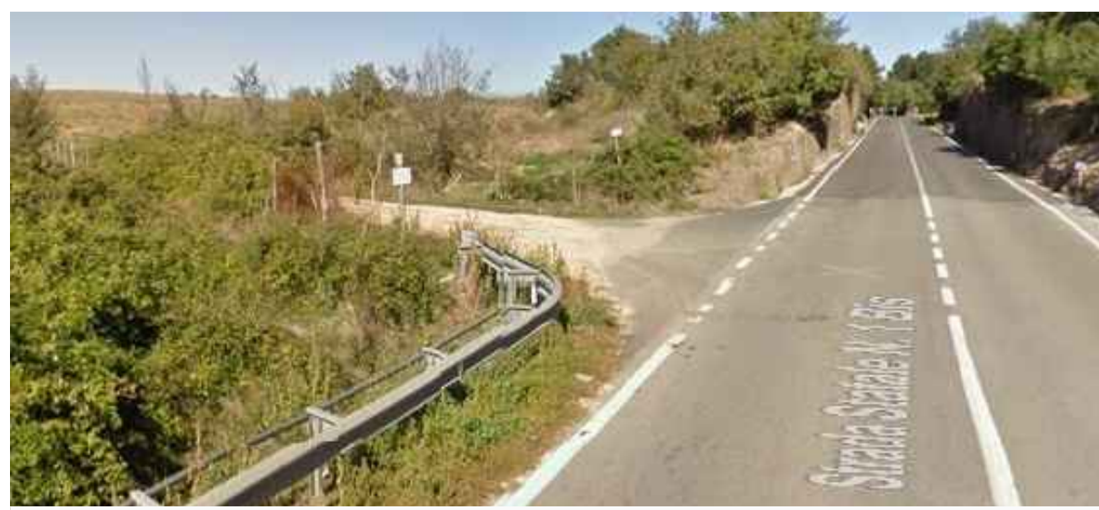
VET003 _ Ingresso cava lungo S.S.1 Aurelia bis
