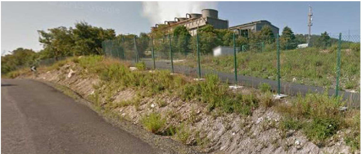
Figura 1 – Cabina primaria ENEL presso centrale geotermoelettrica "Nuova Radicondoli"
