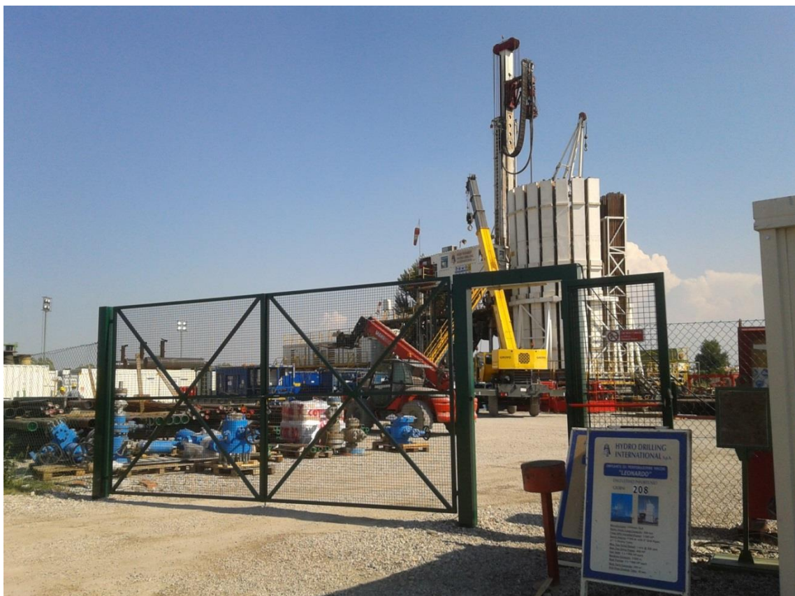
Figura 3-9. Cancelli di entrata alla piazzola di perforazione.
