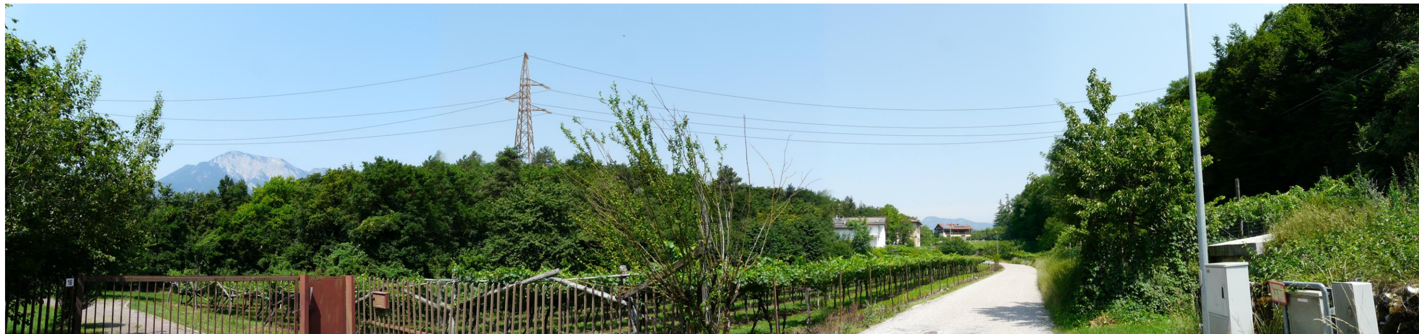
Cono visuale n. 1: panoramica da strada locale di valle dal sostegno n. 29 al n. 28 ex post
