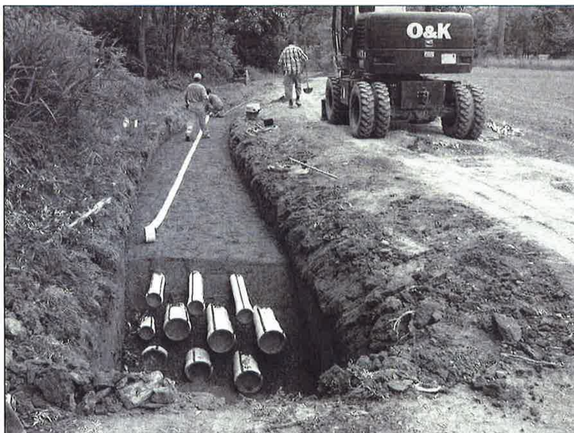
(foto di cantiere 01)
