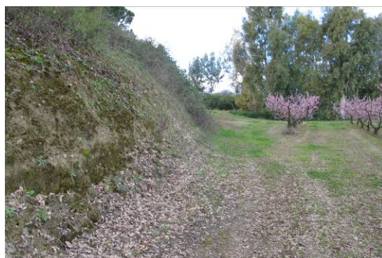
Figura 8 - Vista della scarpata sotto la massiciata stradale
