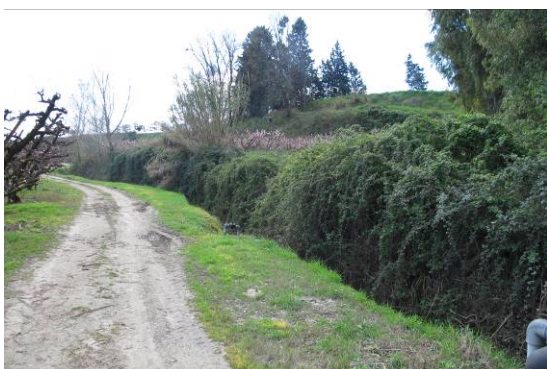
Figura 7 – Vista della scarpata sotto la massiciata stradale
