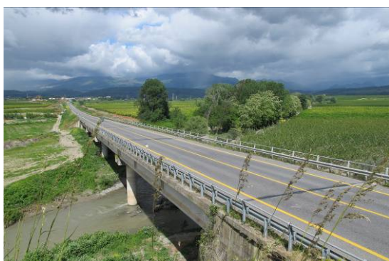
Figura 42 – Vista panoramica del cavalcavia sul fiume coscile
