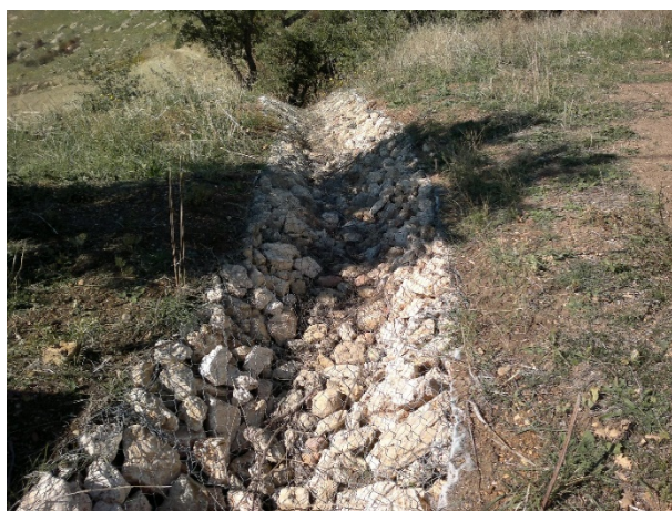
Esempio di intervento con cunetta in pietra e rete zincata
