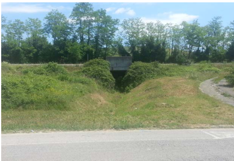
Foto 17 - vista a valle dell'attraversamento ferroviario
