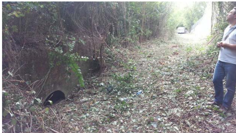
Foto 14 - vista dello sbocco di un tombino stradale da monte della superstrada
