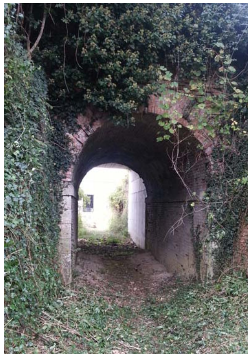
Foto 16 - vista da monte del ponticello di attraversamento ferroviario esistente
