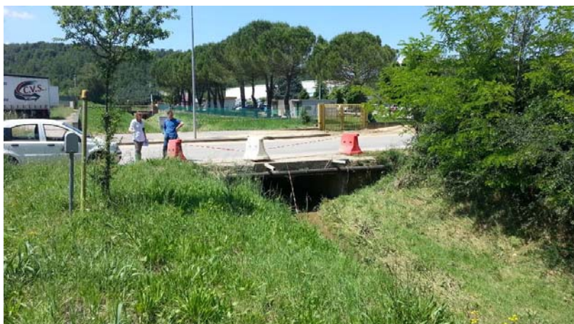
Foto 2 - Fosso Massimina - vista da monte dell'attraversamento di Via della Resistenza
