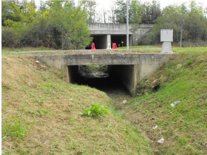
Foto 4 - Fosso Massimina - vista da valle dell'attraversamento di Via della resistenza
