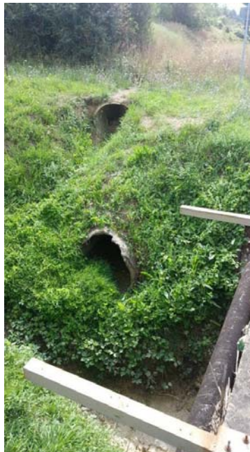
Foto 11 - Fosso di Poggio Orlando - vista dello sbocco del tratto tombato immediatamente a monte dell'attraversamento stradale di Via della Resistenza sul Fosso Massimina
