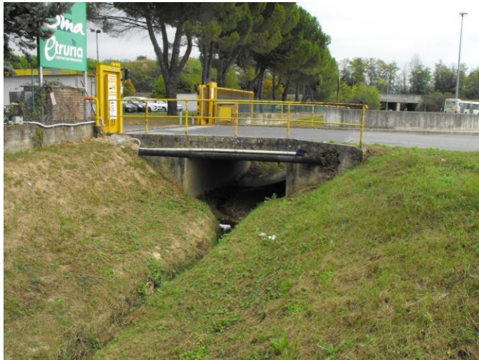
Foto 5 - Fosso Massimina - vista da valle dell'attraversamento per accesso sede Etruria-Simply
