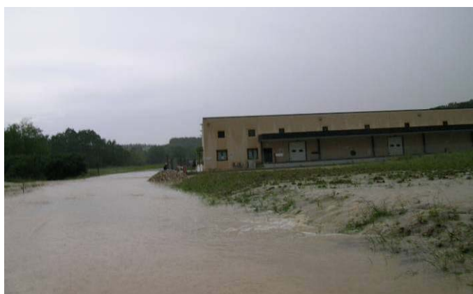
Foto 3 - vista del tratto di nuova viabilità allagata dal Fosso Campo Fiori a monte dello stabilimento Bartolini
