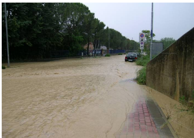
Foto 8 - Fosso di Poggio Orlando - Via della Resistenza (evento maggio 2013)
