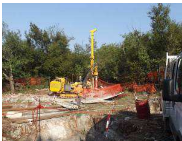
Esempio di realizzazione di una fondazione a micropali (a+b+c)
