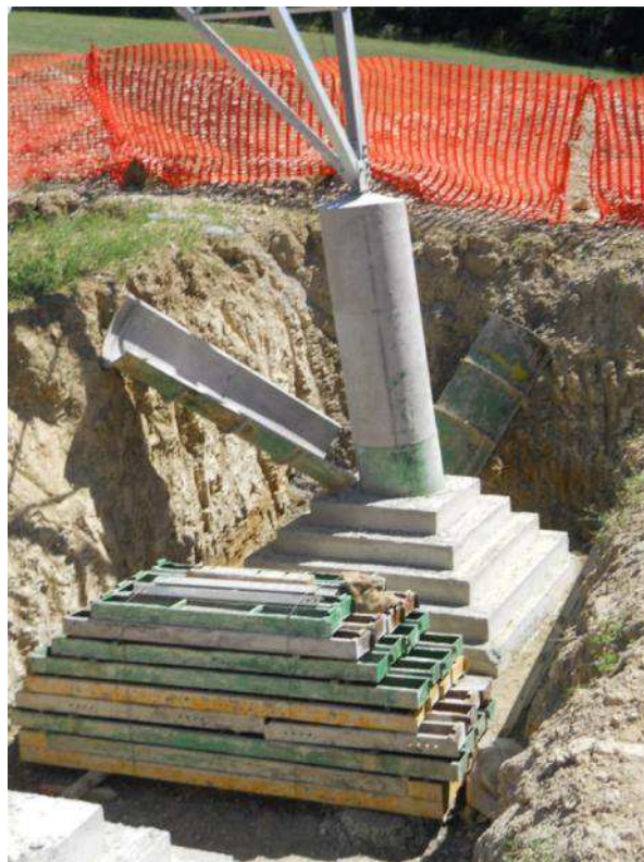
Esempi di fondazione di un sostegno
