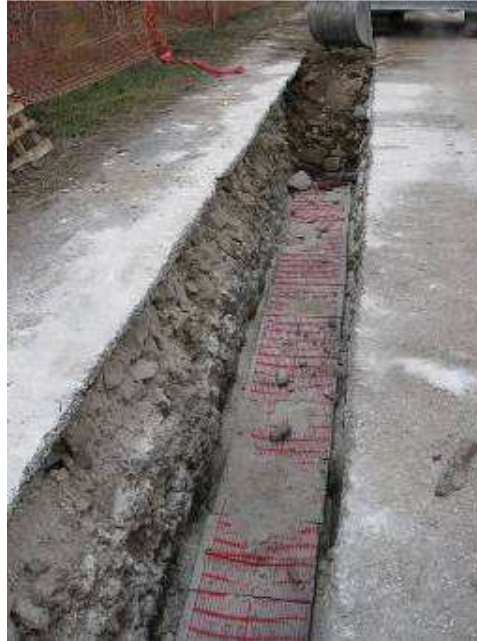
Rinterro con posa delle piastre di protezione e rete in PVC
