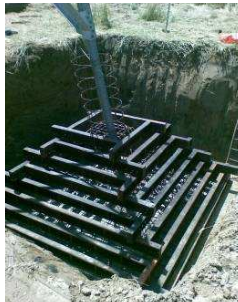
Esempio di realizzazione di una fondazione a plinto con riseghe (a+b)
