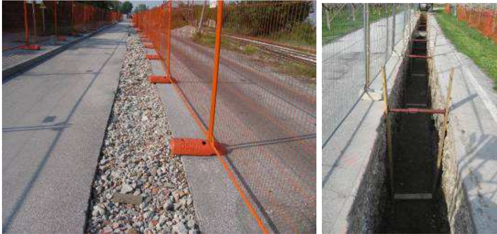
Taglio dell'asfaltatura e scavo aperto
