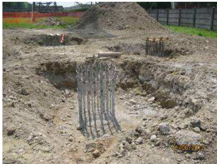
Esempio di realizzazione di una fondazione a trivellati (a+b+c)
