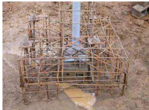
Esempio di fondazione con tiranti in roccia (a+b+c)
