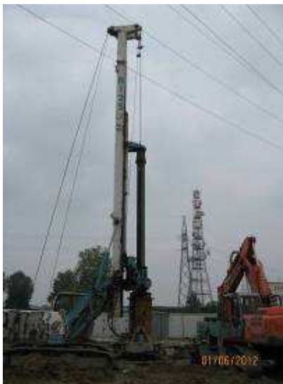
Esempio di realizzazione di una fondazione a trivellati (a+b+c)
