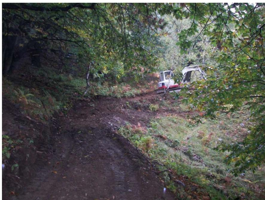
Figura 8: Foto raffigurante un esempio di pista di cantiere Tipo II.
