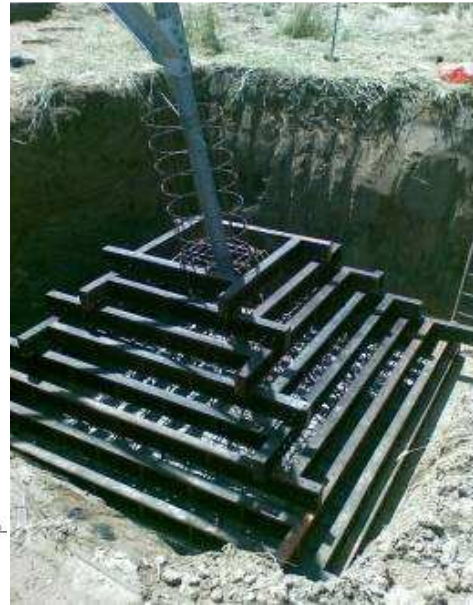
esempio di realizzazione di una fondazione a plinto con riseghe
