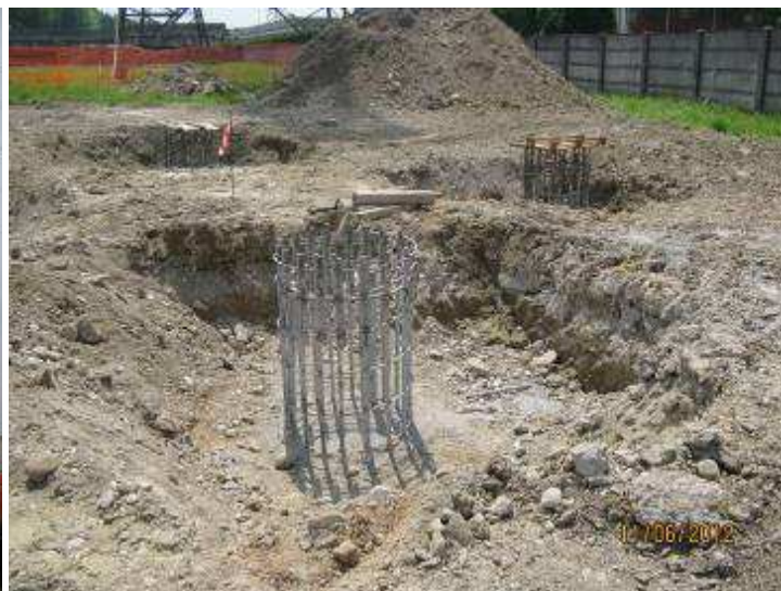
esempio di realizzazione di una fondazione a trivellati
