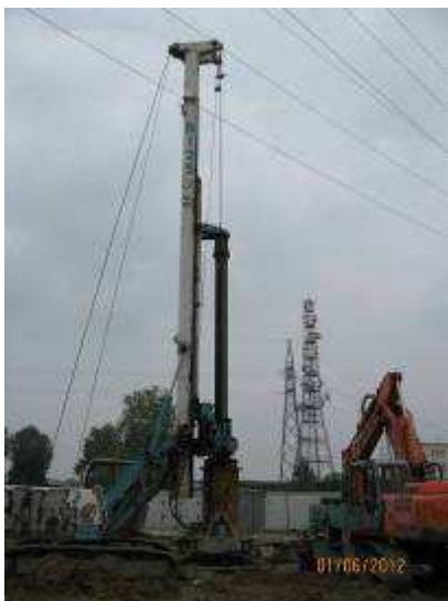
esempio di realizzazione di una fondazione a trivellati
