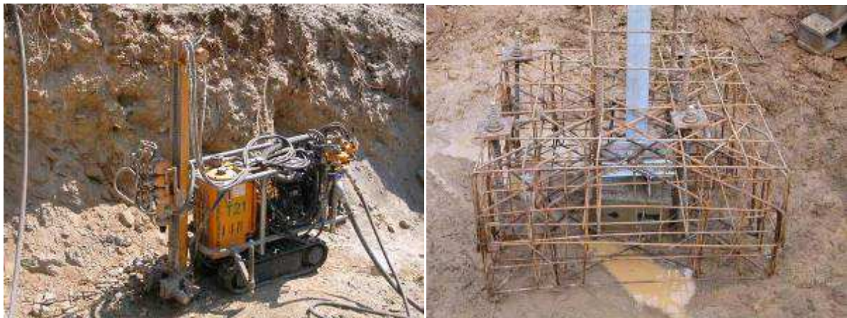
esempio di fondazione con tiranti in roccia
