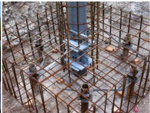
esempio di realizzazione di una fondazione a micropali
