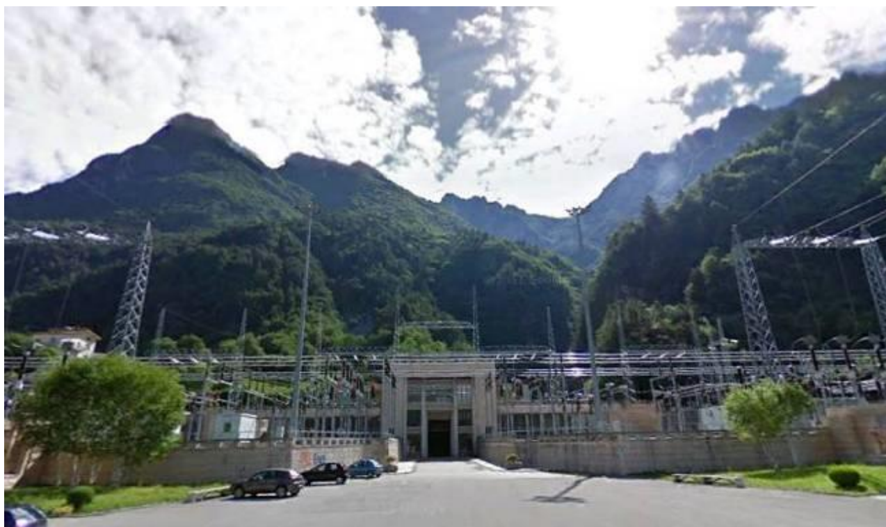
Figura 17: Ingresso alla centrale di Soverzene
