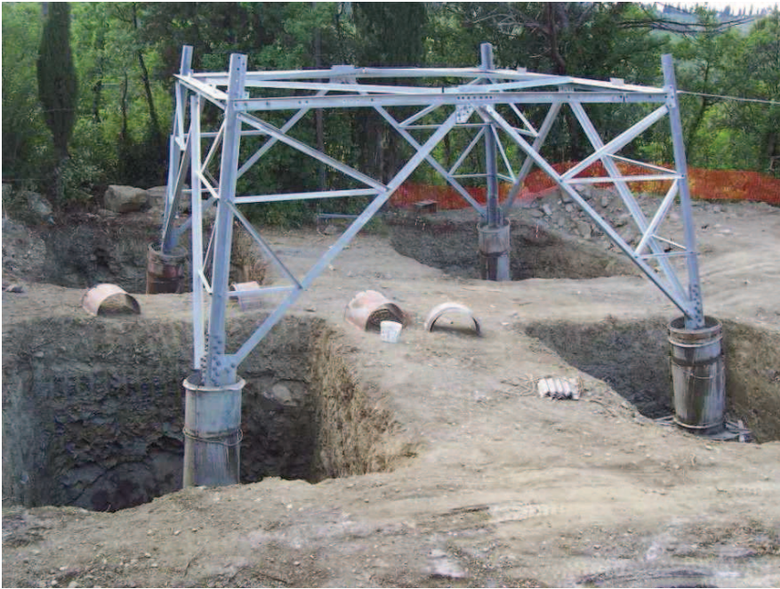
Figura 2-23. Esempio di fondazione di un sostegno.
