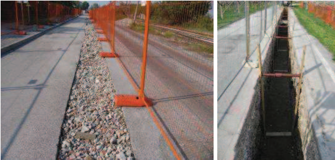
Figura 2-46. Taglio dell'asfaltatura e scavo aperto.
