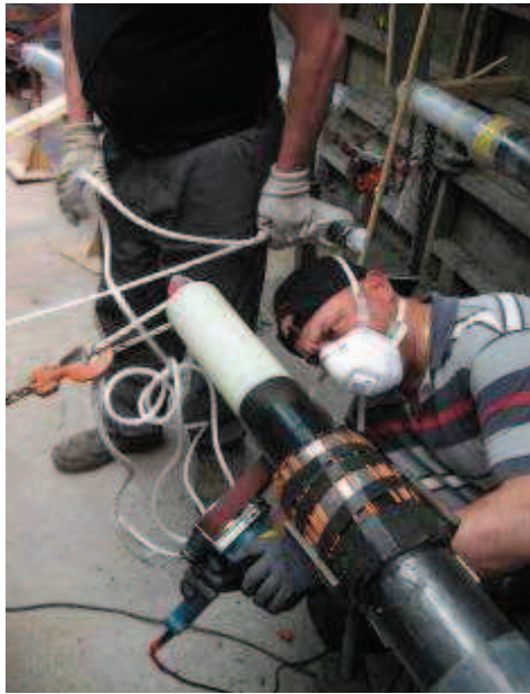
Figura 2-48. Esecuzione giunto.
