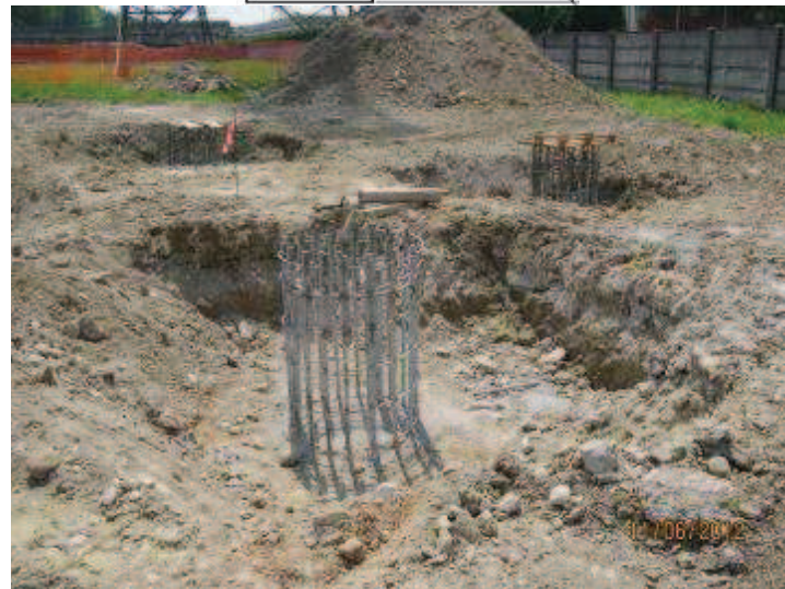
Figura 2-26. Esempio di realizzazione di una fondazione a trivellati
