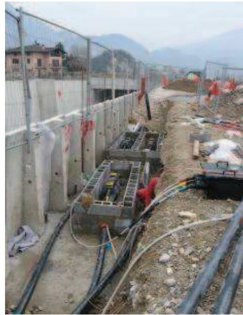
Figura 2-49. Esempio di buca giunti
