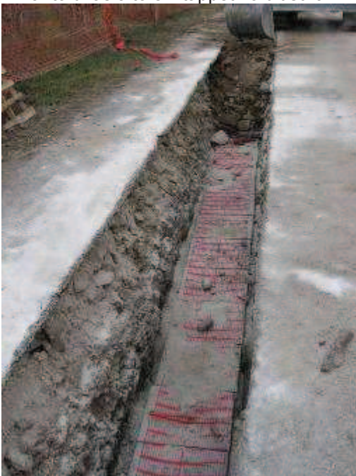
Figura 2-50. Reinterro con posa delle piastre di protezione e rete PVC.
