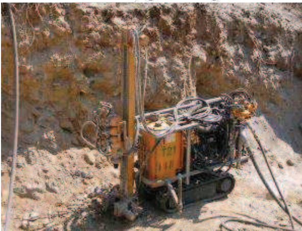
Figura 2-25. Esempio di fondazione con tiranti in roccia.
