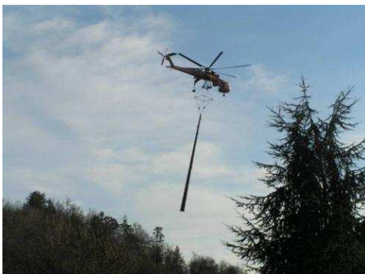
Figura 3-8 Trasporto di un sostegno con elicottero Erickson
