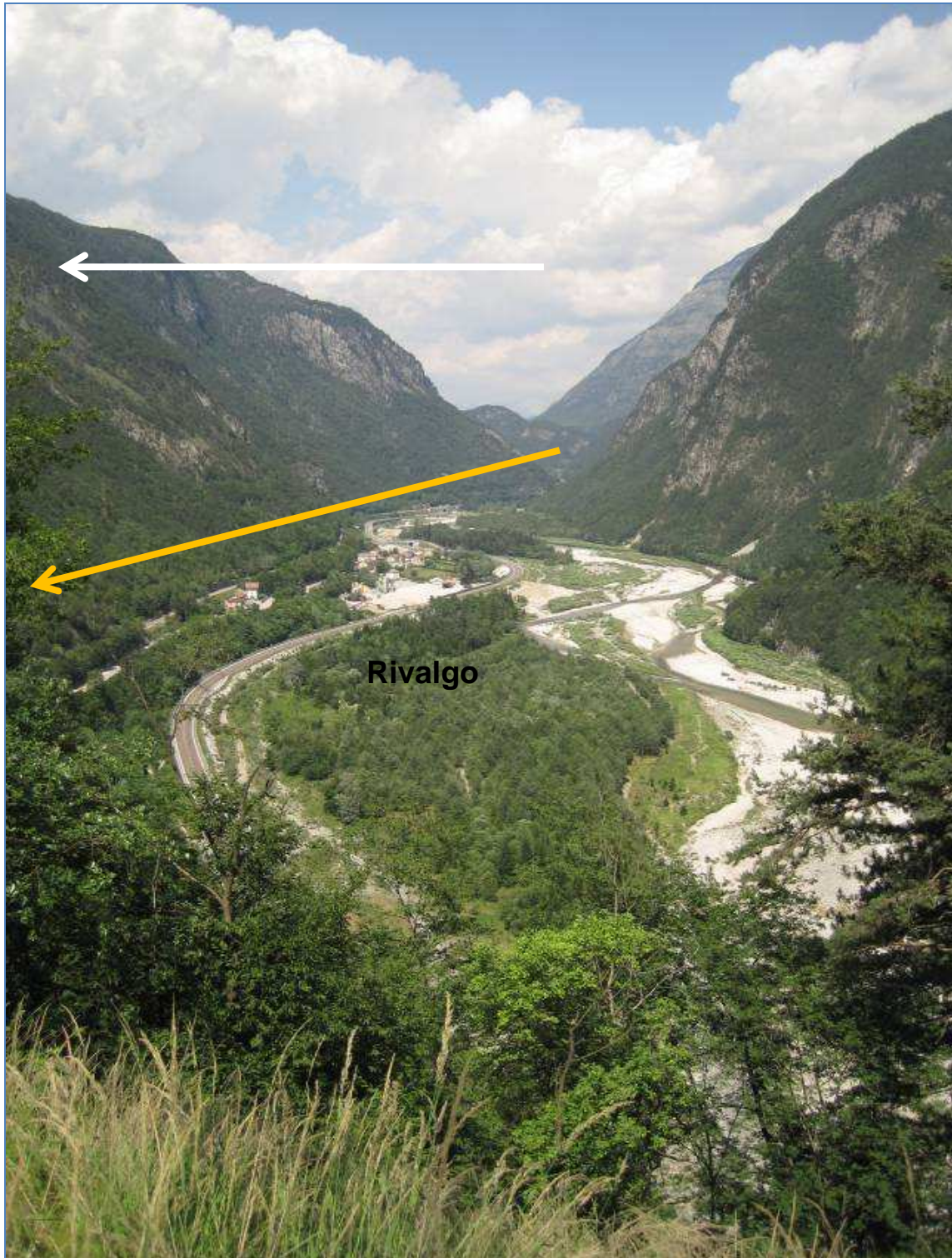
Figura 6-8 I pochi rapaci diurni che attraversano il canale del Piave utilizzano una linea di migrazione (freccia bianca) che si colloca ad una quota superiore rispetto alla linea di passaggio dell'elettrodotto (freccia arancione).
