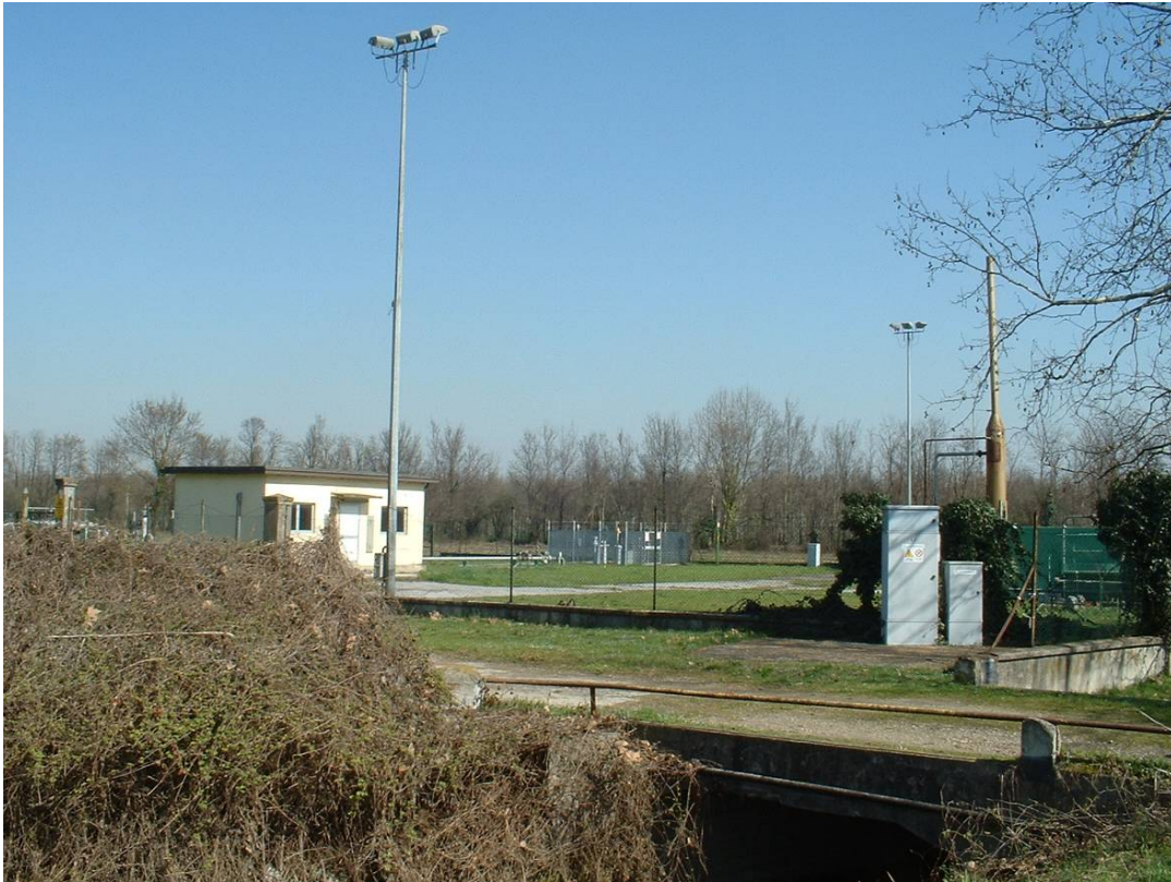
Fotografia 15 – Vista dal percorso lungo il Canale Muzza (Centrale e cluster A)
