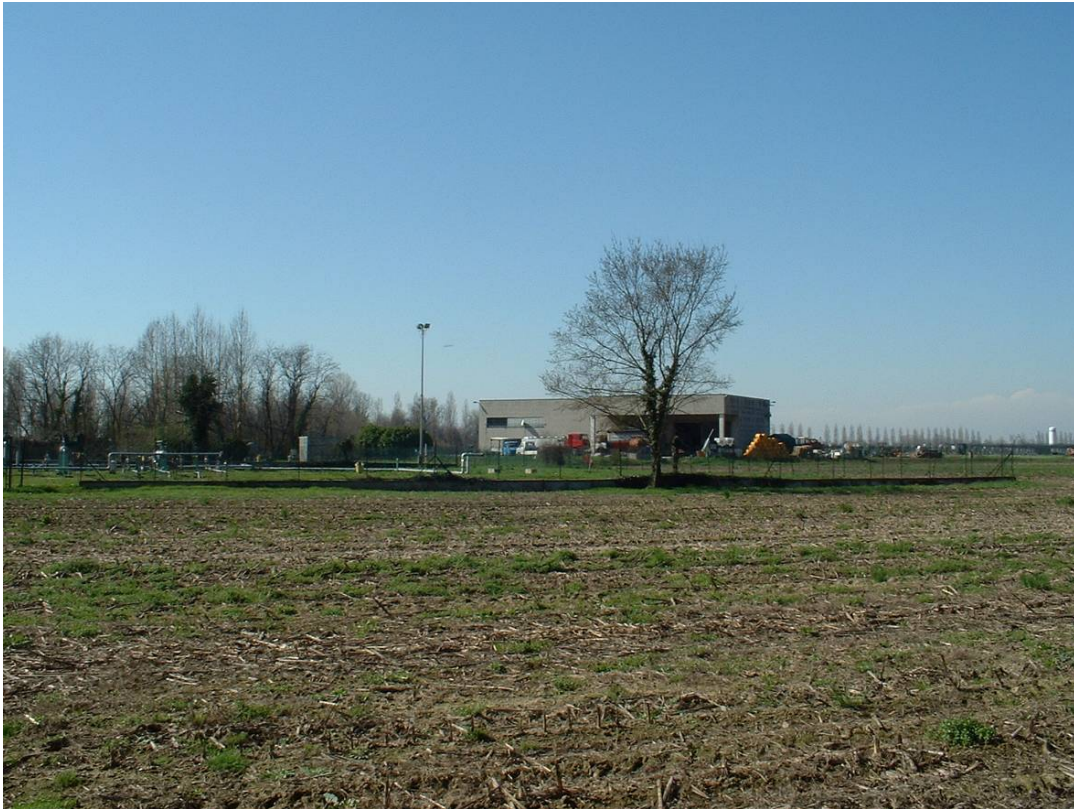
Fotografia 14 – Vista della centrale dalla roggia (Centrale)
