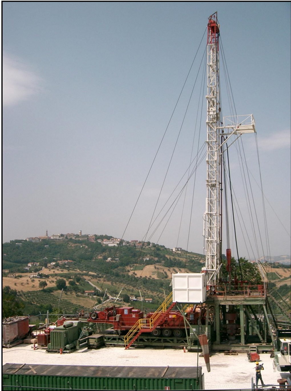
Figura 4.3.5.1a Esempio di Impianto di Perforazione con Potenzialità 1.500 m
