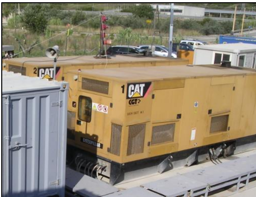
Figura 4.3.5.1d Generatori Elettrici ad Alta Insonorizzazione
