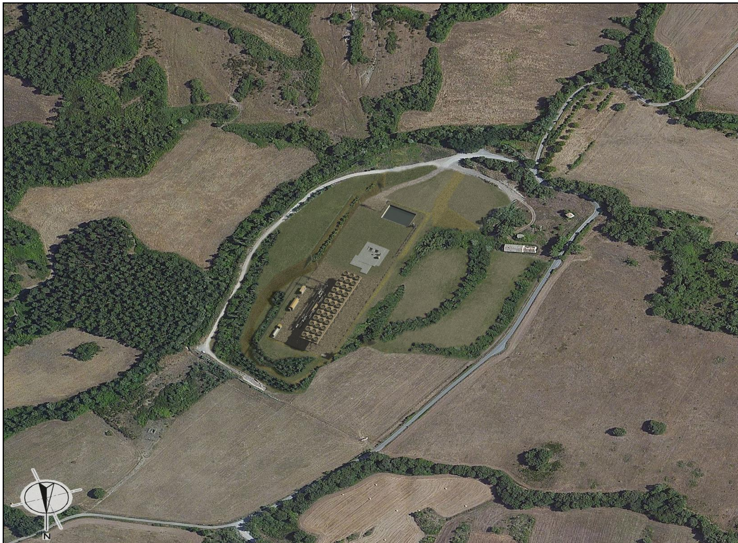
Figura 4.3.6.2b Inserimento Paesaggistico Postazione AP2 ed Impianto ORC – Post Operam
