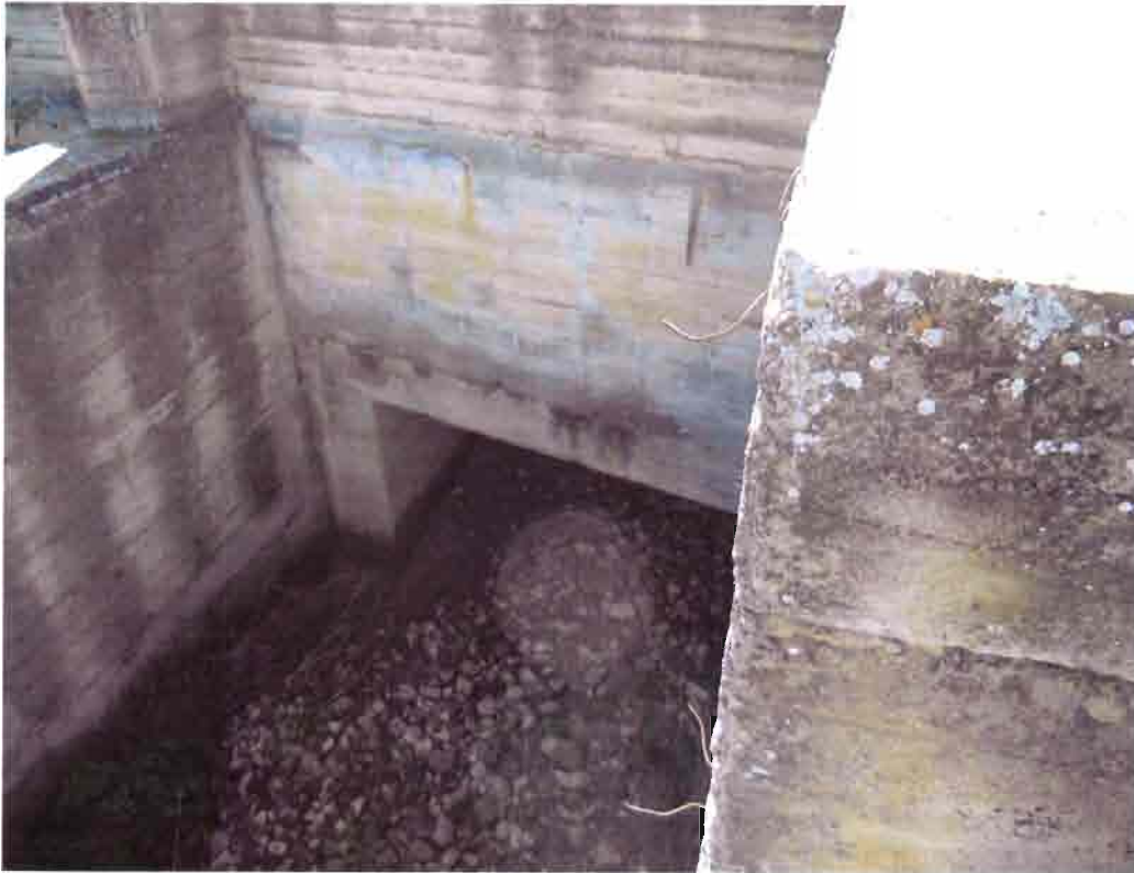
Figura 23: Attraversamento autostradale Mulinello.
