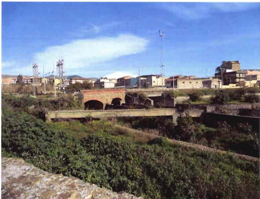
Figura 18: Attraversamento ferroviario torrente Mulinello – Vista da valle
