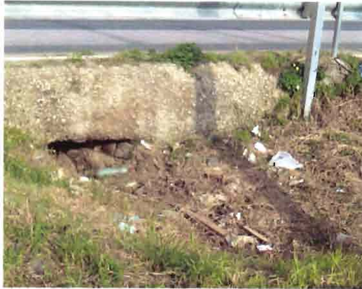
Figura 37: Sbocco condotta lungo via Enna.
