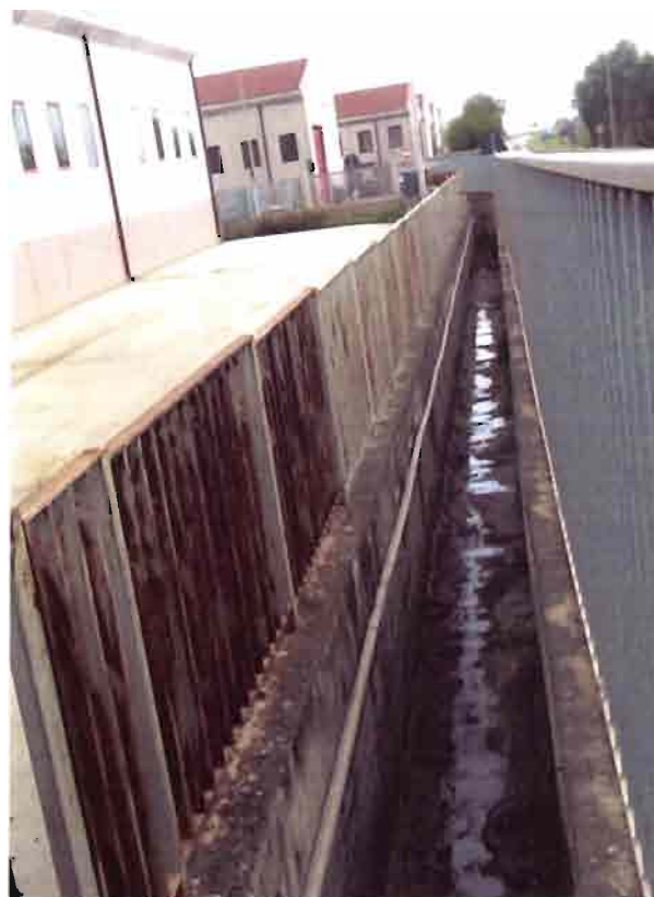
Figura 38: Canale in cls zona artigianale.
