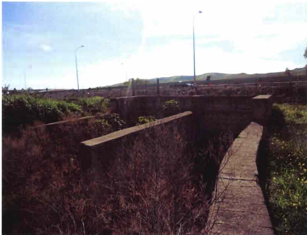
Figura 22: Attraversamento autostradale Mulinello.
