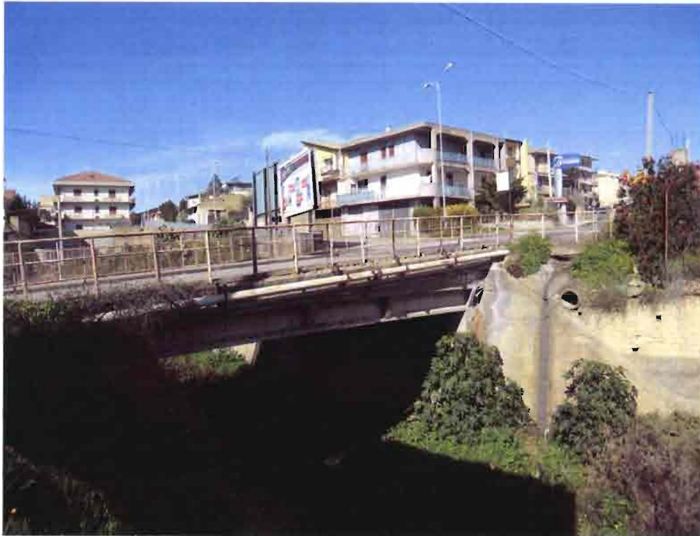
Figura 17: Attraversamento via Stazione – Vista da monte
