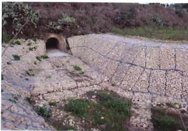
Figura 14: Attraversamento ferroviario torrente Mastropaolo – Vista da valle
