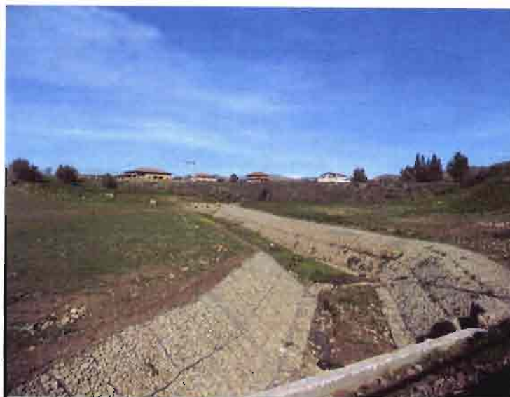
Figura 15: Attraversamento ferroviario torrente Mastropaolo – Vista da valle
