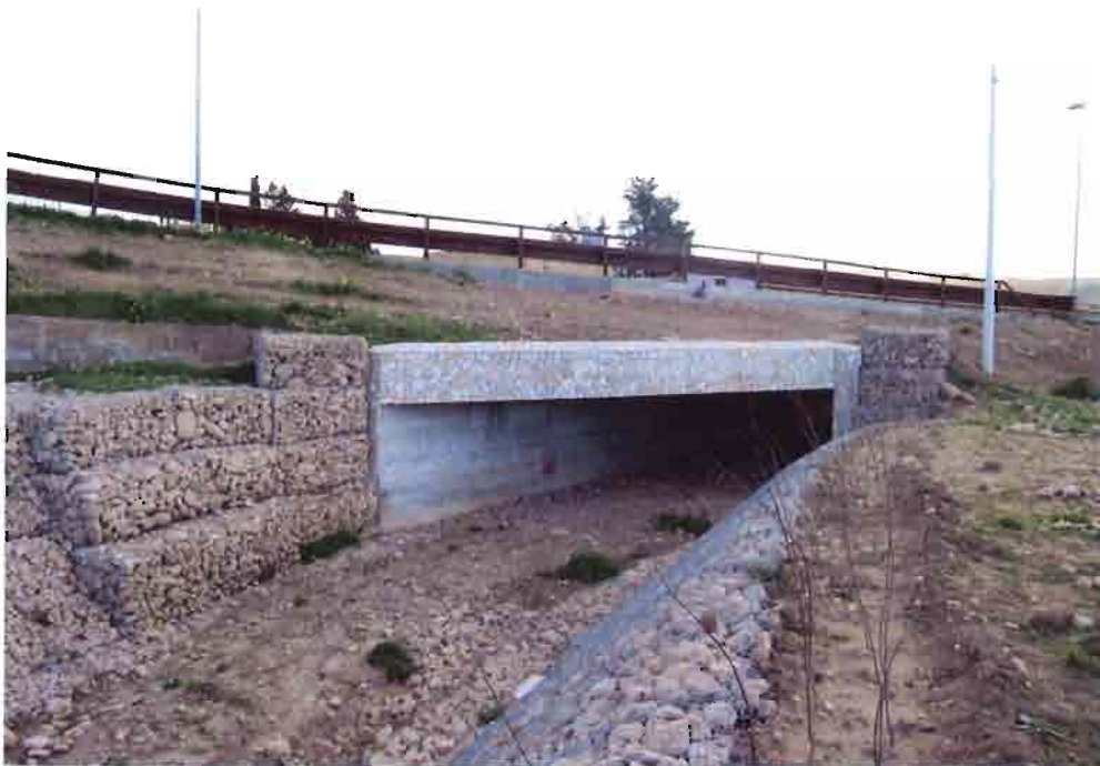
Figura 16: Attraversamento via dei Caduti in Guerra torrente Mastropaolo – Vista da monte
