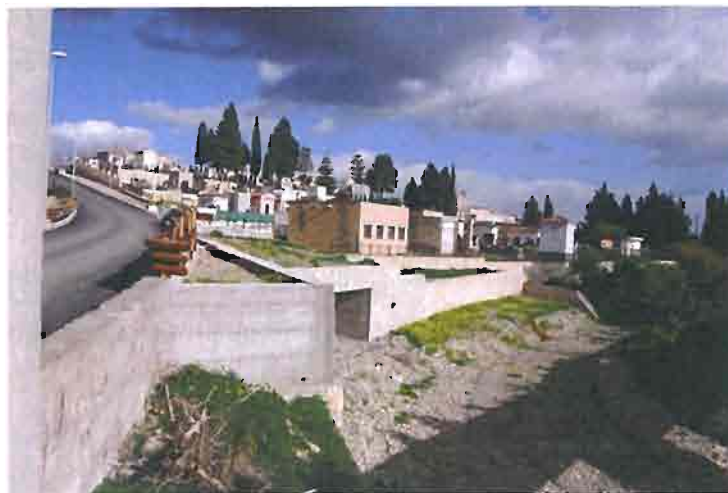
Fig. 9. Muri esistenti in corrispondenza del fosso Petroso
