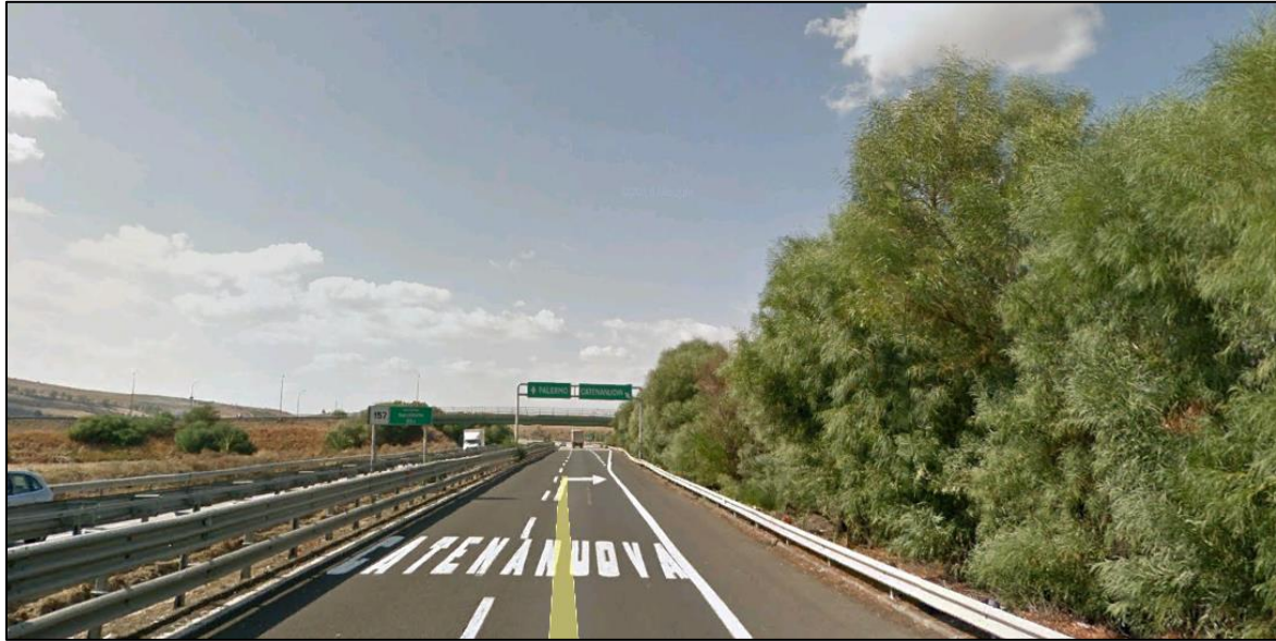
Figura 2-14: Vista n. 1 dall'autostrada A19, in direzione Palermo
