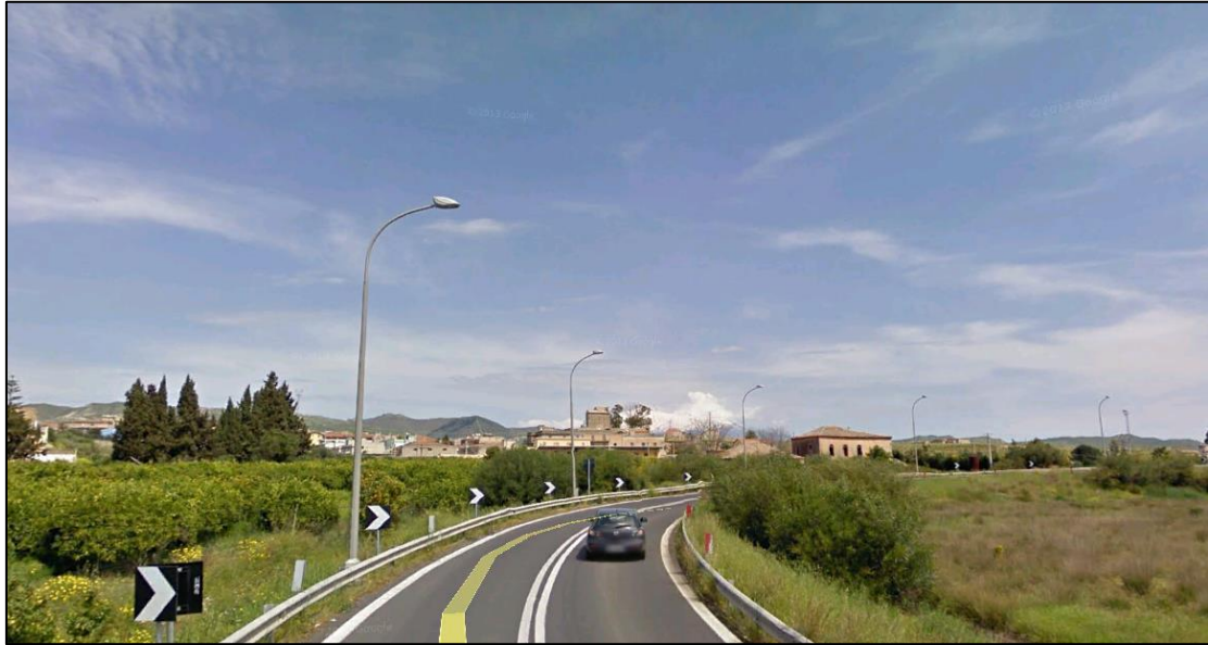
Figura 2-16: Vista n.3 dall'autostrada A19, lungo lo svincolo autostradale di Catenanuova
