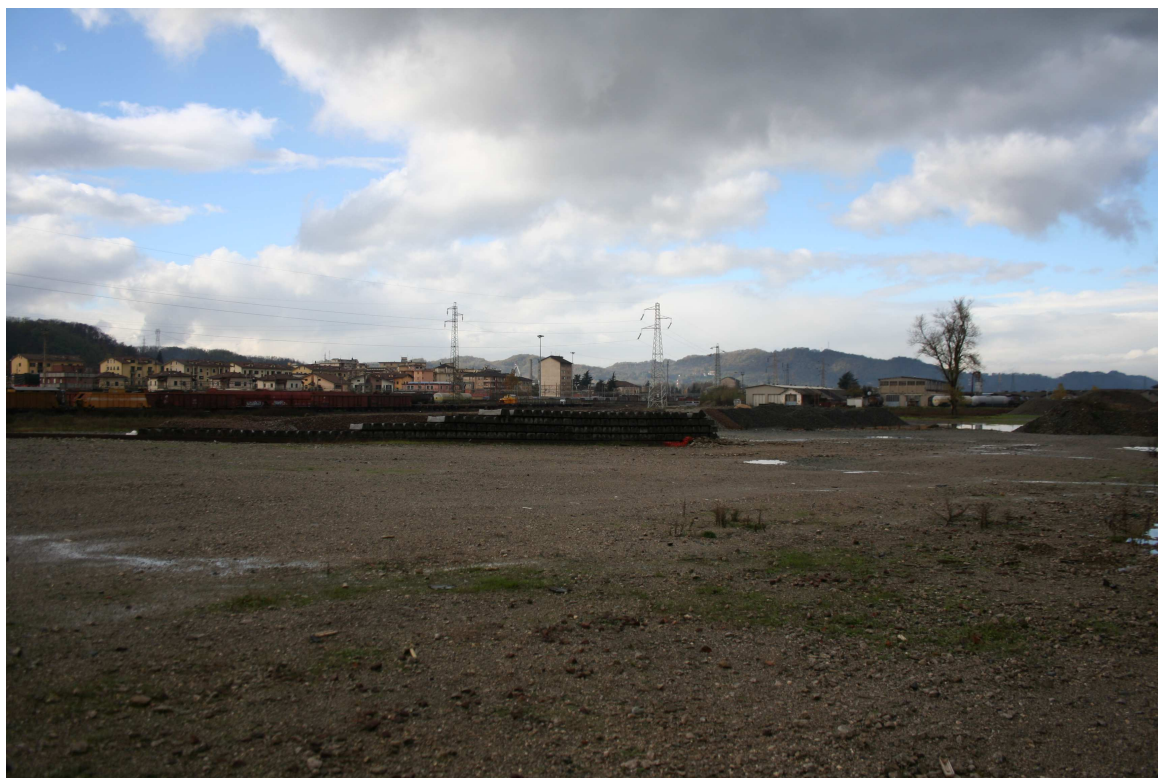
PANORAMICA DELL'AREA DI CANTIERE
