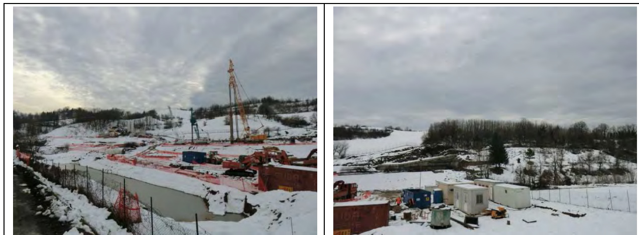
Figura 3.1 – COP20: area di cantiere - vista da nord
