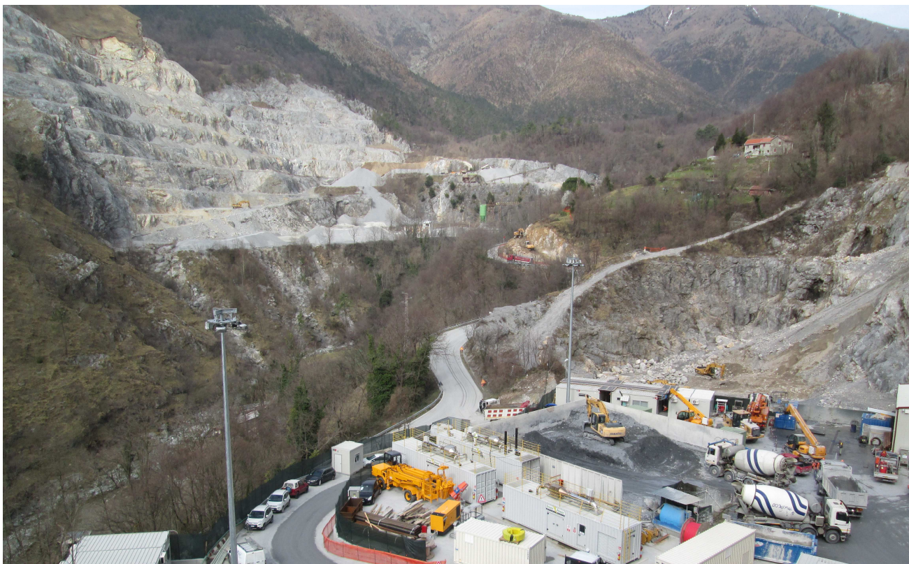
Figura 6-2 Riprese fotografiche dal cantiere verso l'area di cava Castellaro
