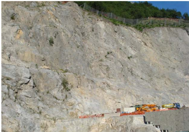
Cava Grandi nei pressi dell'imbocco della Finestra Cravasco. La parete è priva fenomeni di dissoluzione e di cavità di origine carsica.
