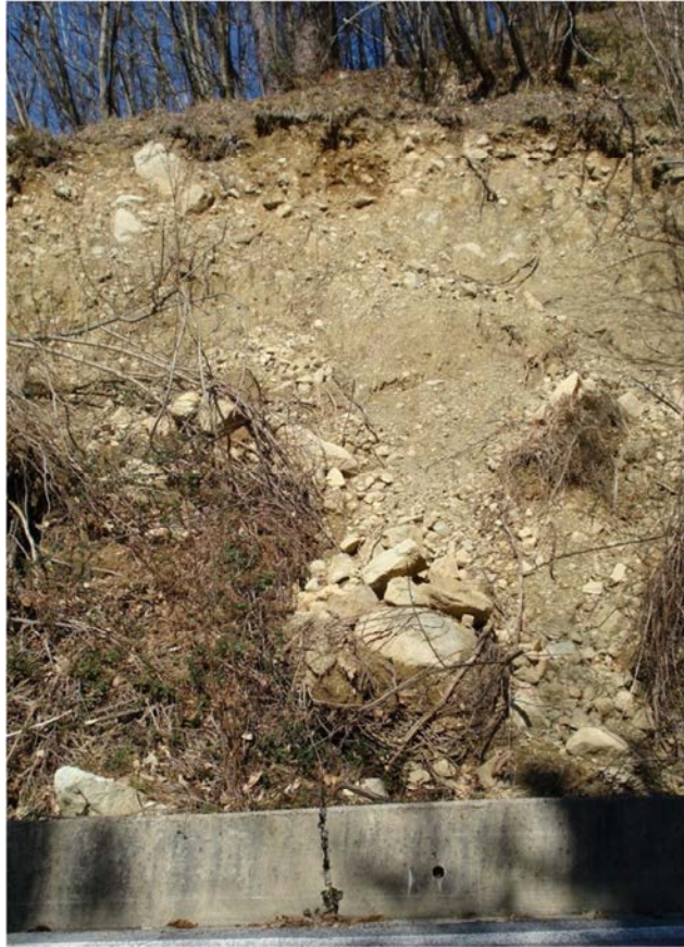
Periferia nord di Cravasco. Una delle dorsali corrispondenti ad un accumulo di frana costituito da materiale eterogeneo con clasti in matrice sabbioso-limoso disposti in maniera caotica.
