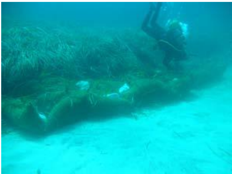
Esempio di realizzazione di biostuoia e immersione lungo il margine inferiore della prateria di Posidonia.
