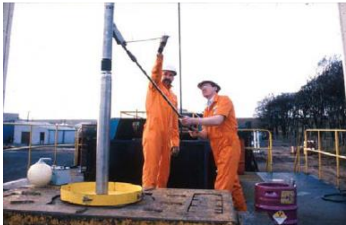
Figura 3-6: Inserimento sorgente all'interno della sonda
