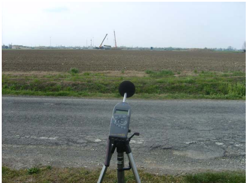
Vista area di cantiere
