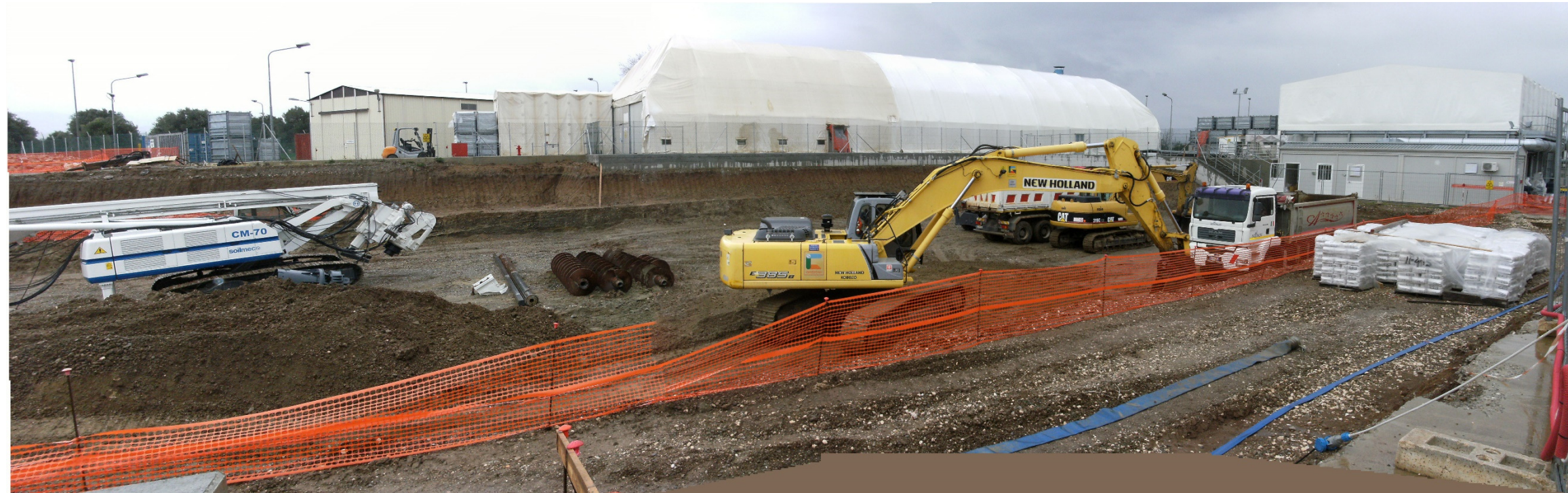
Figura 10/6: Area di cantiere lato Sud-Est
