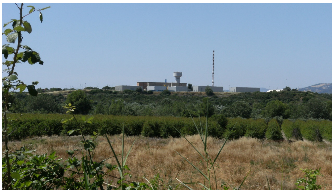
Figura 10/3: Alveo del fime Sinni a Nord del Sito
