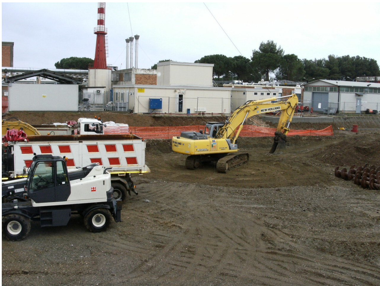
Figura 10/5: Area di cantiere lato Ovest
