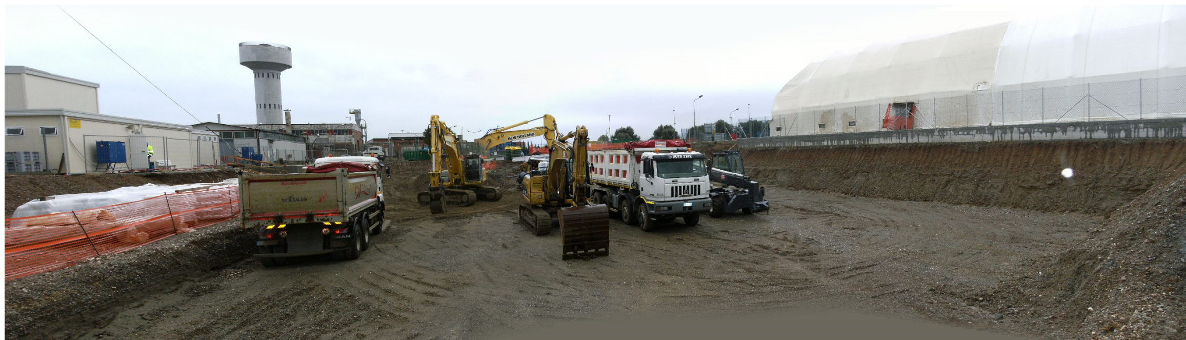
Figura 10/7: Area di cantiere lato Nord
