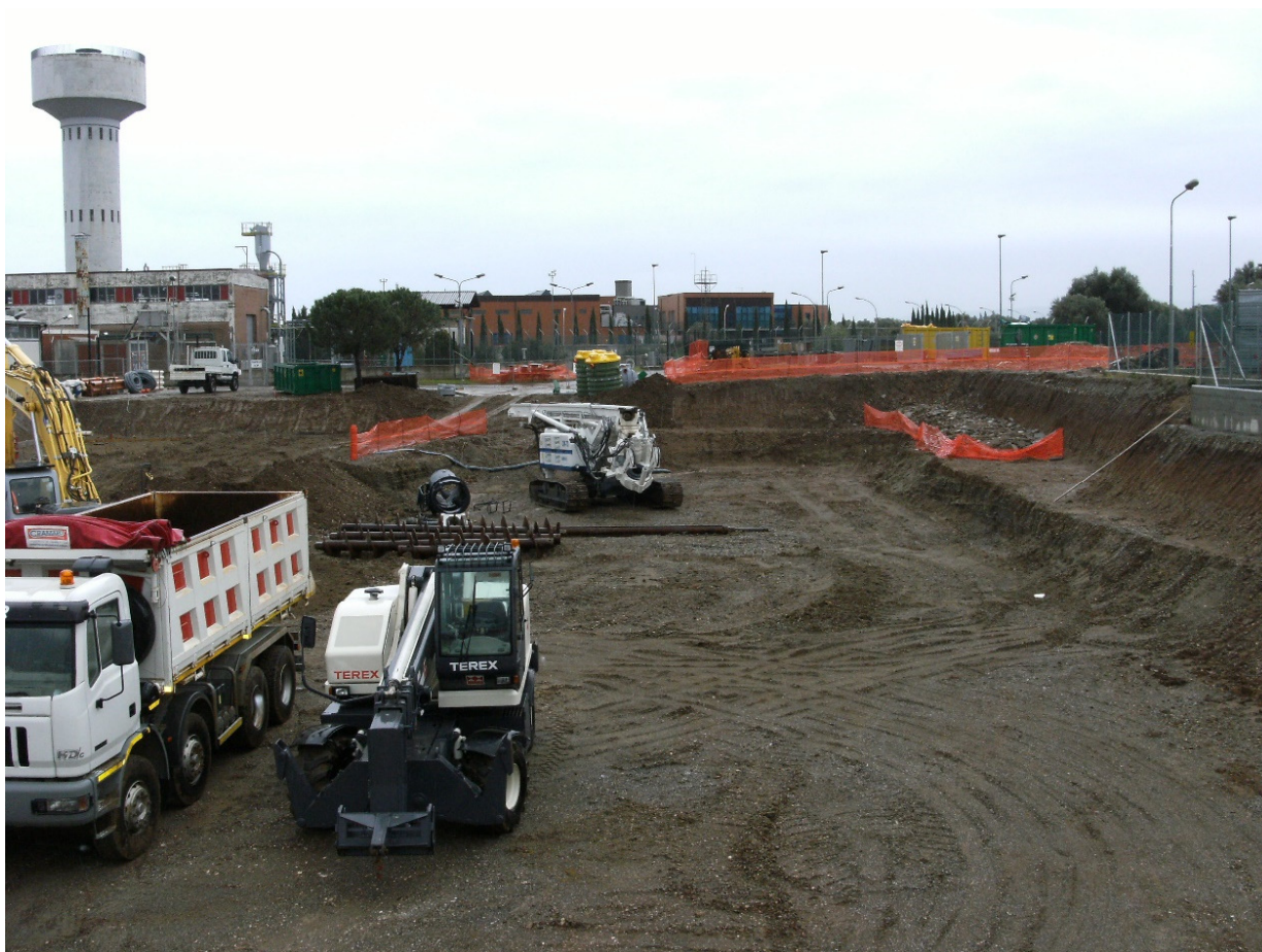
Figura 10/4: Area di cantiere lato Nord
