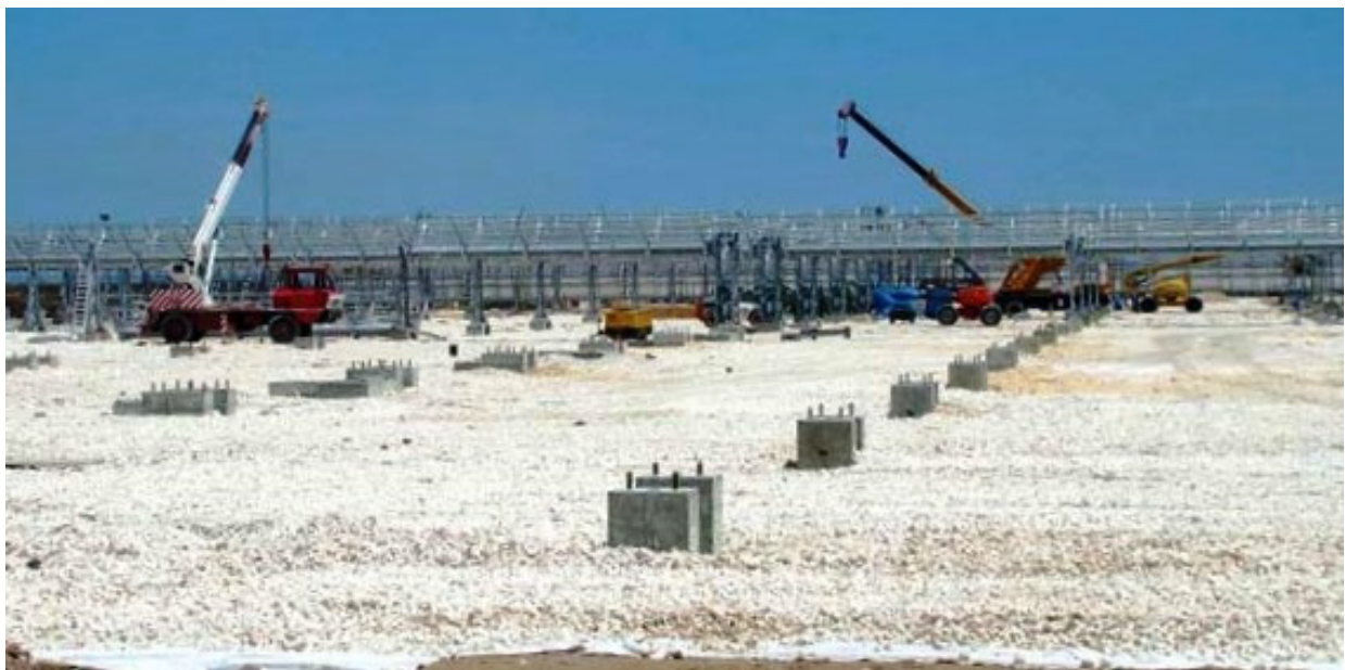
Fig. 1 – Plinti della centrale termodinamica Archimede – Priolo Gargallo, Messina
