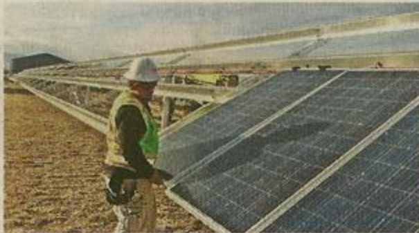
Installazione di pannelli solari termodinamici
