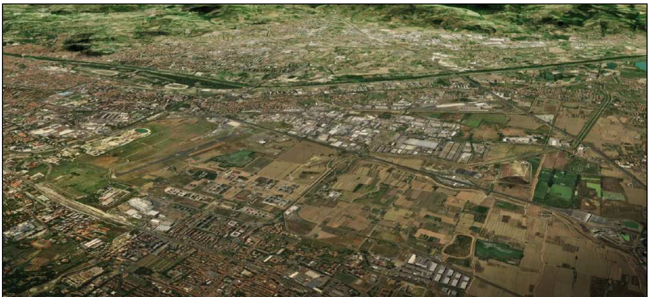
Vista dell'area di intervento in direzione sud-est
