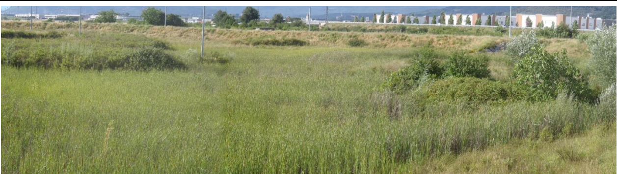
Area 4: aspetto della cassa d'espansione presso la loc. La Querciola (sullo sfondo, a destra): l'area umida presenta ridotta diversità idromorfologica ed una profondità uniforme e relativamente ridotta, che ne compromette la funzionalità ecologica.
