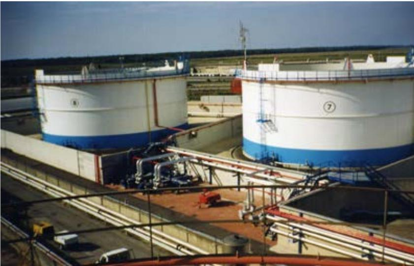
E' scelta del soggetto proponente l'intervento, di modulare l'impianto in modo tale da avere una capacità complessiva per lo stoccaggio del gasolio di circa 24.000 metri cubi utili e di circa 12.000 metri cubi per le benzine. La particolare conformazione planimetrica del sito, la superficie dello stesso, in aggiunta alle restrizioni normative, consentono
