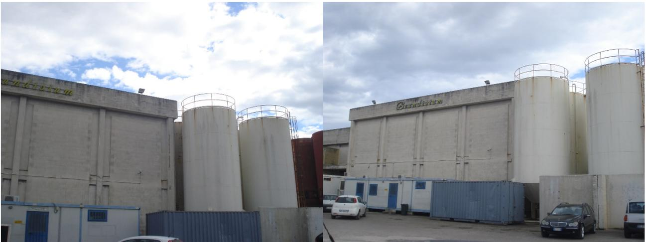
Per la realizzazione delle opere di progetto si prevede preliminarmente la demolizione/dismissione delle opere d'arte esistenti (edifici/serbatoi) e la predisposizione del piazzale per l'accoglimento dei serbatoi di stoccaggio e degli impianti.
