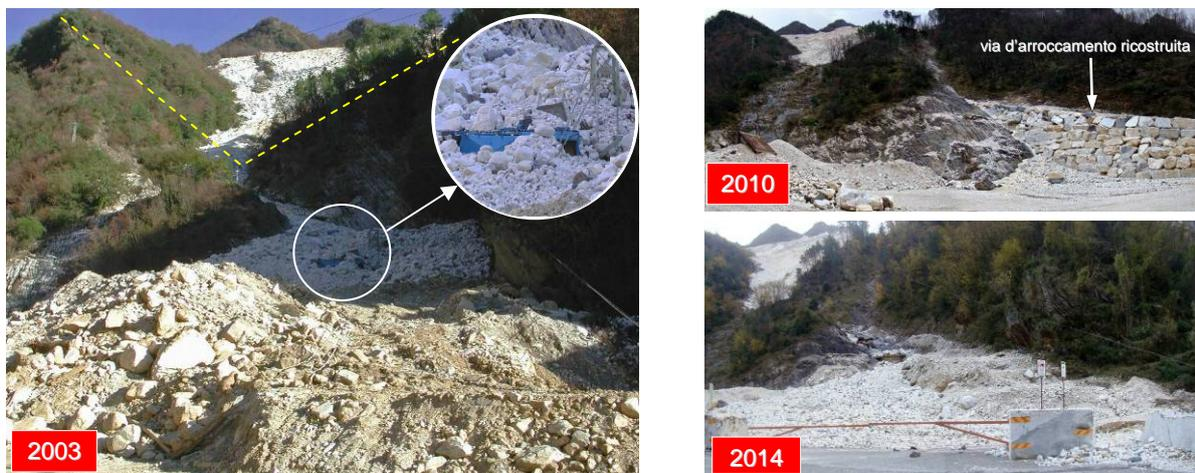
**Fig. 13.** Il ravaneto di Piastra riempie il fondo della valle (i cui versanti sono indicati dalla linea gialla tratteggiata). A sinistra: **nel 2003** il ravaneto è interamente franato, spazzando via la strada d'arrocamento su di esso impostata e seppellendo macchinari (visibili nel cerchio). A destra: **nel 2010**, con la via d'arrocamento ricostruita, e **nel 2014**, nuovamente franato.
