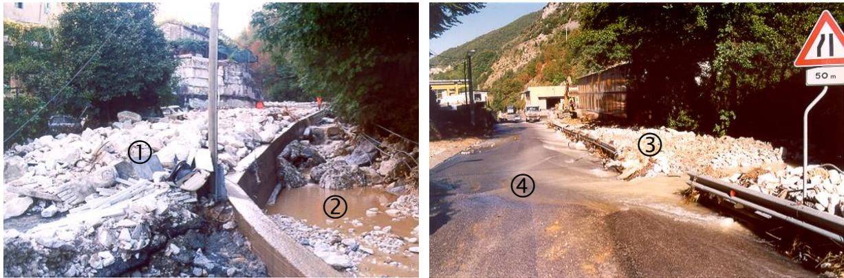
**Fig. 12.** Via Colonnata presso Mortarola dopo l'alluvione del 23/9/2003. **1)** strada invasa da detriti di ravaneto, di notevole pezzatura; **2)** alveo del Carrione, fortemente ristretto; **3)** alveo del Carrione stracolmo di detriti di ravaneto, ad una quota addirittura superiore al piano stradale (fino alla sommità del guard-rail); **4)** strada già sgomberata dai detriti.
