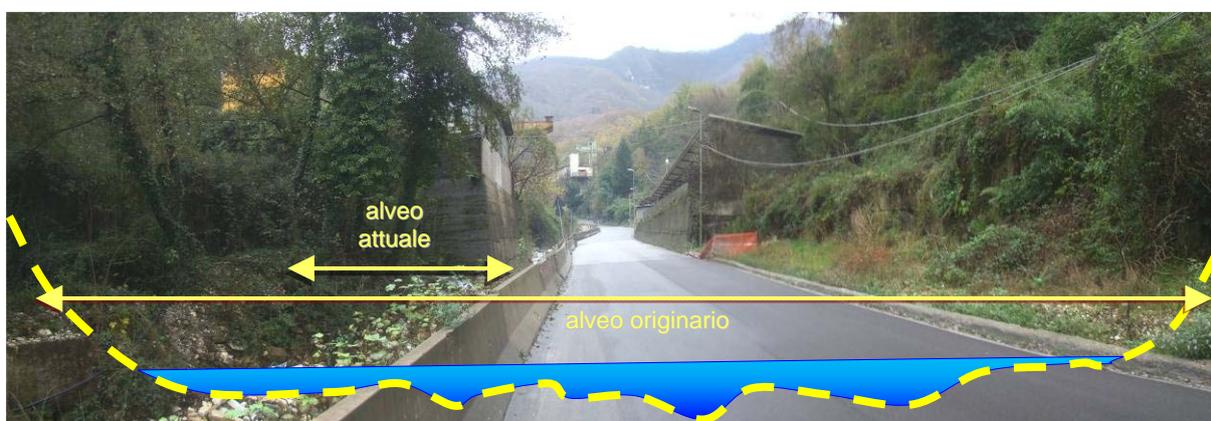
**Fig. 2.** Via Colonnata, loc. Canalie. Lo schizzo sovrapposto alla foto rappresenta l'alveo originario, oggi in gran parte occupato dalla sede stradale. Nell'alveo attuale, confinato in una sede ristretta e arginata, le piene scorrono dunque con maggior velocità (per la minor larghezza e la maggior profondità); per la bassa scabrezza dell'asfalto, anche le acque che esondano sulla strada scorrono rapidamente verso valle.
