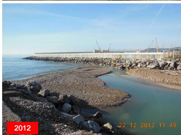
**Fig. 22.** La barra di foce del Carrione, costituita da ciottoli e terre tendenti a consolidarsi, è un deposito naturale all'interfaccia acque correnti (torrente) e stagnanti (mare); si riforma perciò dopo ogni intervento di rimozione.
