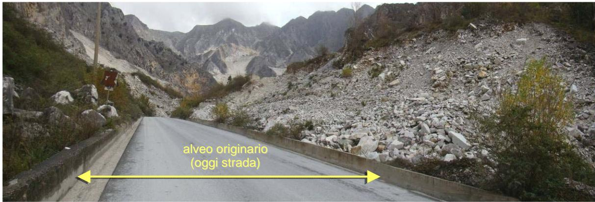
**Fig. 4.** Via Battaglino-Ravaccione (bacino di Torano). Il fondo della valle è stato interamente occupato dalla strada. Le acque meteoriche, scorrendo su un "alveo" così liscio e con elevata pendenza, subiscono una forte accelerazione.
