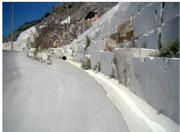
**Fig. 6.** Anche le vie d'arroccamento comprensoriali di Canalgrande e di Fantiscritti, costruite sui ravaneti che hanno colmato gli omonimi fossi, sono asfaltate e dotate di canaline in cemento per lo scolo delle acque. Una soluzione razionale per il transito dei camion, ma l'esatto contrario di quanto desiderabile per rallentare il transito delle acque meteoriche: il vantaggio locale si traduce in un aggravamento del rischio alluvionale a Carrara.
