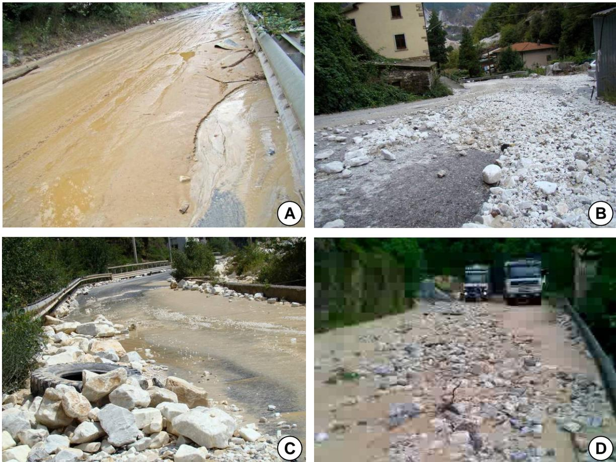
**Fig. 16.** Fanghi e detriti di ravaneti trascinati sulle strade dalle precipitazioni. **A)** via Piastra (Torano); **B)** via Canaloni (Colonata); **C)** via Battaglino (Torano); **D)** via Carriona per Ravaccione (Miseglia): i detriti impediscono il transito dei camion.
