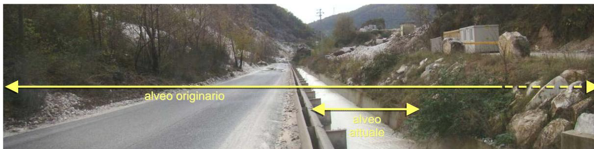
**Fig. 7.** Via Piastra (a monte di Torano). L'alveo del Can. di Piastra (Carrione di Torano), già fortemente ristretto per la costruzione della strada, è stato recentemente risistemato rinnovandone il rivestimento in cemento per aumentarne l'officiosità idraulica. In occasione di forti precipitazioni le acque sono costrette a scorrere su un substrato a scabrezza molto bassa (cemento o asfalto), accentuando l'impulsività del regime torrentizio.
