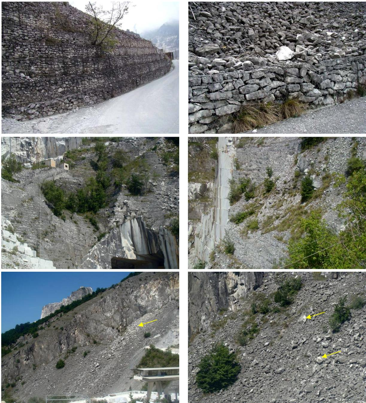
**Fig. 10.** I vecchi ravaneti, stabili e costituiti quasi interamente da scaglie, non apportano sedimenti agli alvei, mentre (immagazzinando acqua e rallentandone i deflussi superficiali) riducono il rischio idraulico: vanno perciò mantenuti. Le ultime due foto, relative ad un ravaneto sostanzialmente stabile, mostrano quanto sia facile –grazie alle scheggiature bianche (freccie)– individuare perfino i singoli clasti che hanno subito un rotolamento negli ultimi anni.
