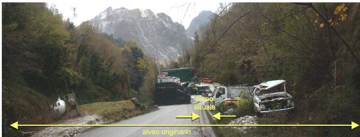
**Fig. 3.** Via Canaloni, a monte di Colonnata. La strada è stata costruita in pieno alveo riservando al deflusso delle acque la sola canalina stradale. È ovvio che con le forti precipitazioni l'alveo diventi l'intera strada, accelerando fortemente il deflusso e aggravando perciò il rischio alluvionale a Carrara.
