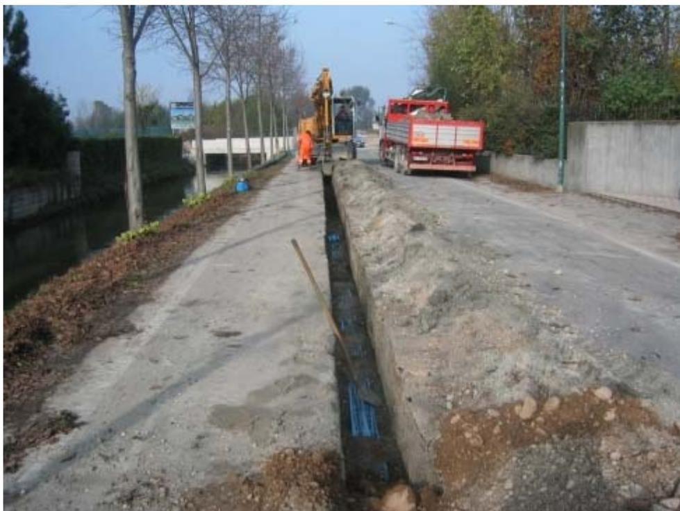
Figura 4 – Situazione tipo di posa tubo lungo strada
