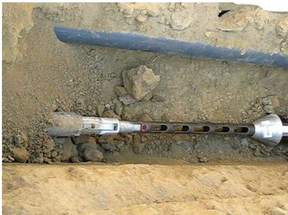
Figura 8 – Situazione tipo di posa tubo mediante tecnologia No Dig. Esempio di posa tubi paralleli
