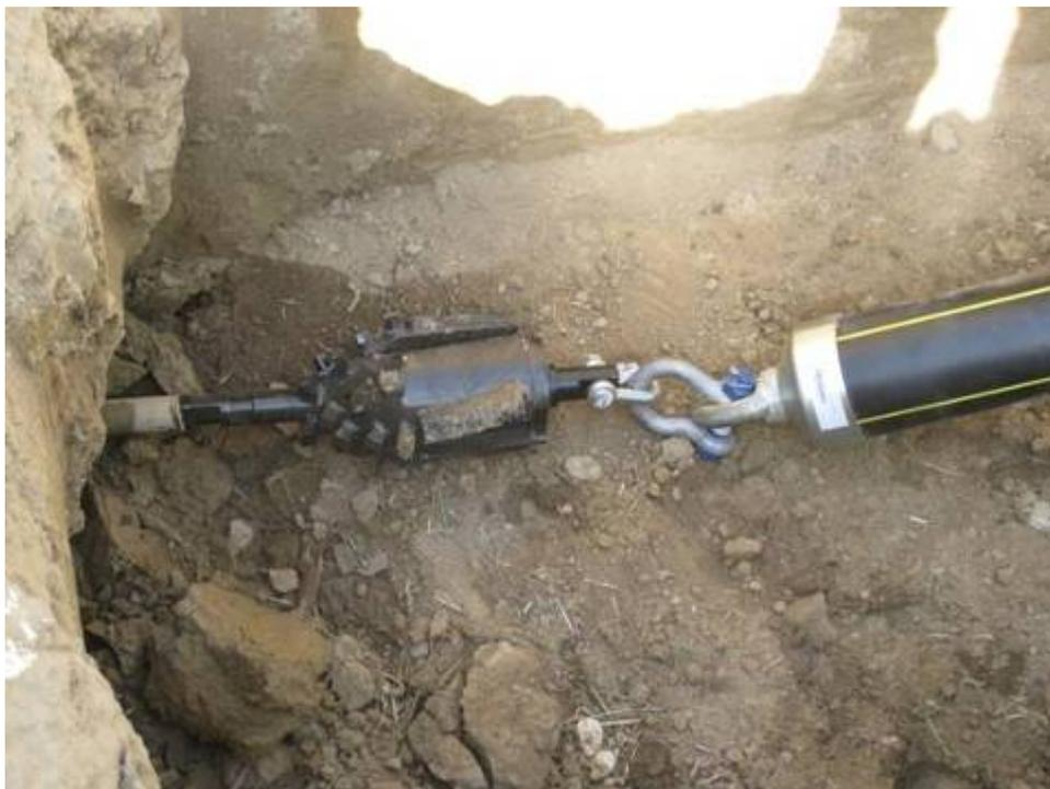
Figura 9 – Situazione tipo di posa tubo mediante tecnologia No Dig. Fase di aggancio tubo e infilaggio nel foro precedentemente realizzato
