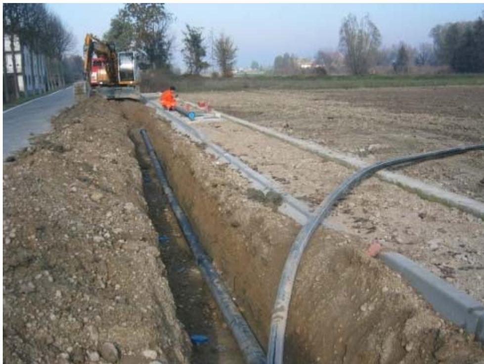
Figura 5 – Situazione tipo di posa tubo lungo banchina
