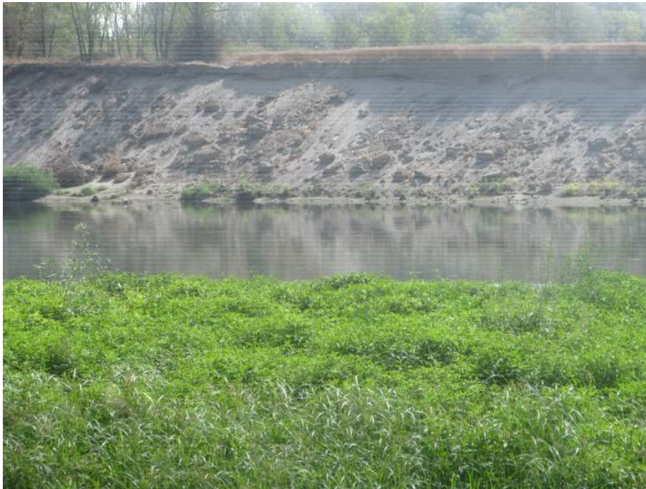
vista da sponda sx verso valle
