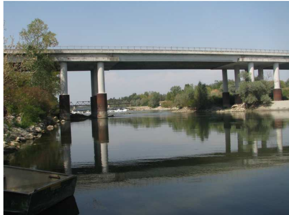
vista da sponda dx verso monte (a valle del ponte)
