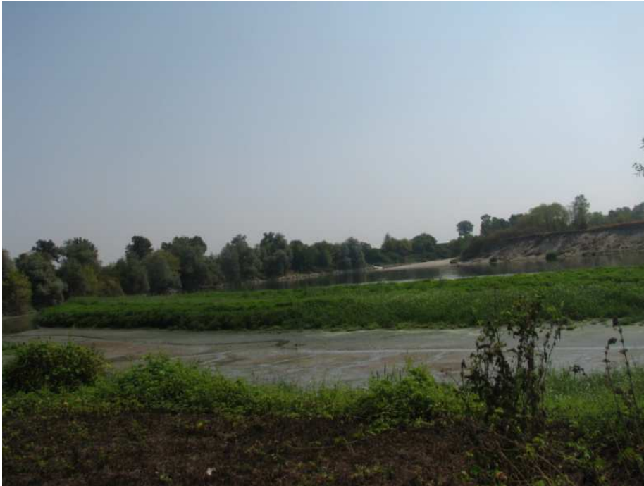
vista da sponda sx verso valle
