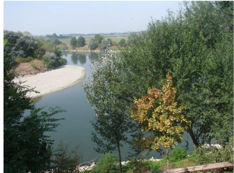
vista da sponda sx verso monte
