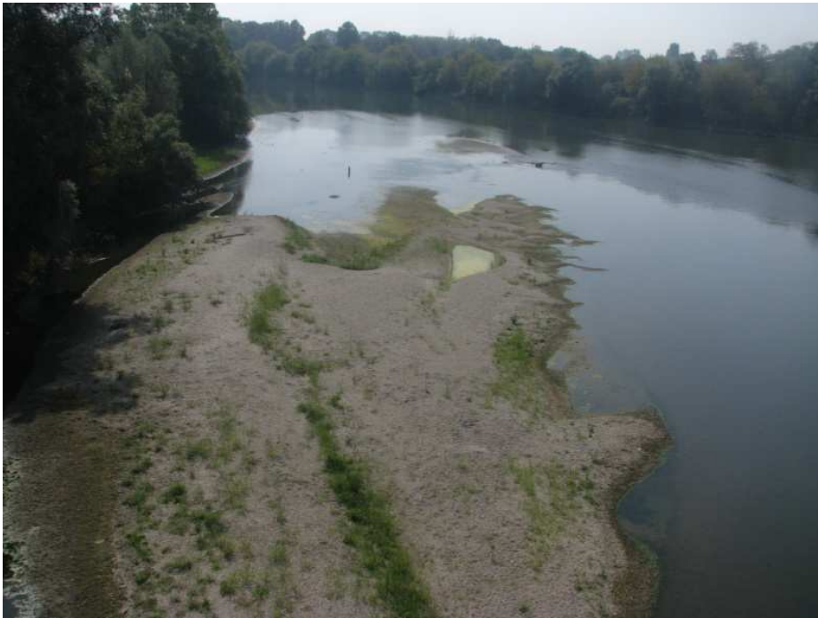
vista da sponda sx verso valle
