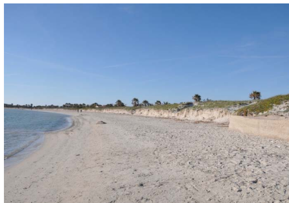
Figura 5 Settore meridionale della spiaggia-emersa, interessato dai processi di erosione del campo dunale, solcato da accessi pedonali non regolamentati. Si evidenzia la presenza in spiaggia di strutture rigide realizzate a protezione degli edifici retrostanti.
