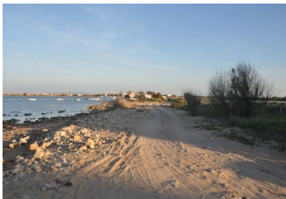
Figura 4 Sistema di accessibilità carrabile e di sosta veicolare non regolamentata insistente nel settore di retrospiaggia. Si evidenzia la ricarica di materiali inerti per la sistemazione dell'accesso.
