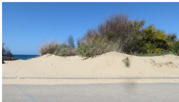
Figura 8 Depositi sabbiosi costituiti dai sedimenti mobilizzati dal vento e trasportati sull'infrastruttura stradale viaria.
