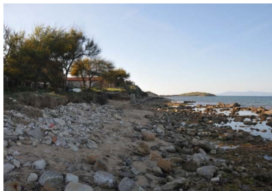
Figura 5 Materiale inerte residuo prodotto dal disfacimento ad opera del moto ondoso dei manufatti insistenti sul campo dunale.
