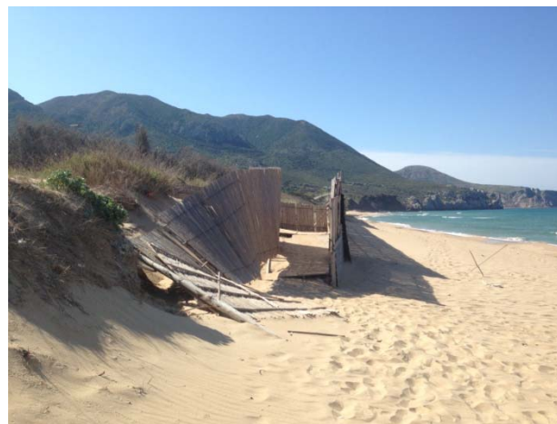
Figura 11: Accessi alla spiaggia costituiti da passerelle e protetti con schermi frangivento.
