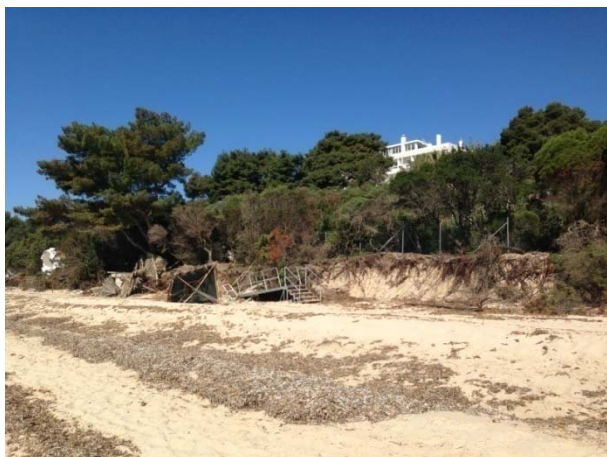
Figura 4 Ripa di erosione del sistema dunale stabilizzato, con interessamento delle strutture di accesso alla spiaggia.
