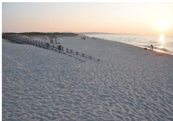
Figura 5 Passerella lignea di accesso pedonale alla spiaggia, parzialmente ricoperta da accumuli e depositi sabbiosi.
