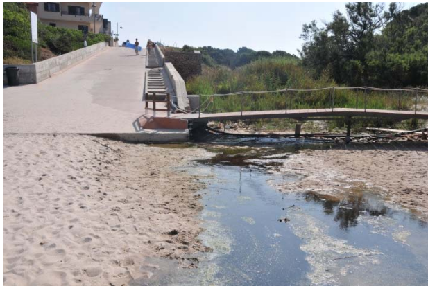
Figura 4 Particolare della strada cementata di accesso alla spiaggia e della depressione umida in cui si raccolgono le acque provenienti dai settori interni.
