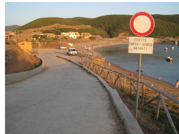
Figura 6 Infrastruttura stradale e area sosta realizzate nell'ambito di retrospiaggia.
