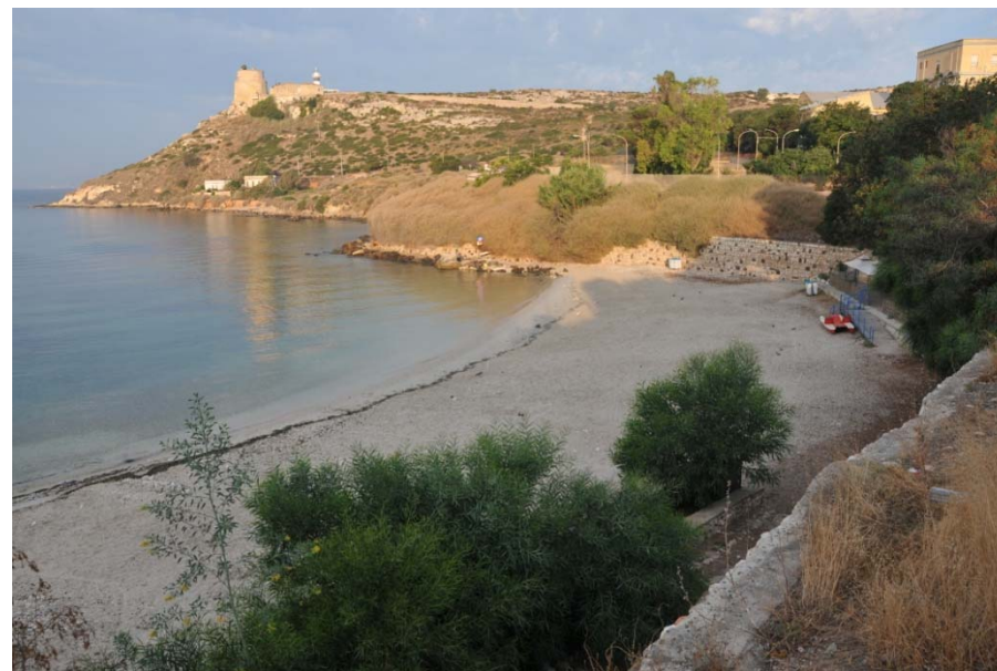
Figura 5 Settore occidentale della spiaggia caratterizzato dalla presenza di opere rigide, quali i muri di sostegno delle scarpate.
