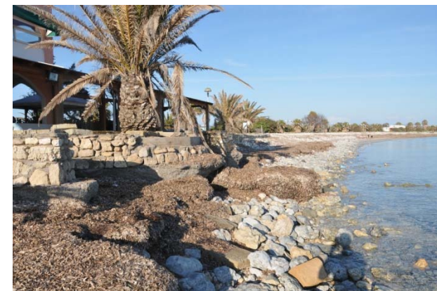
Figura 6 Settore settentrionale della spiaggia in cui sono presenti strutture fisse destinate ad attività turistico-ricreative interessate da processi di smantellamento ad opera della dinamica meteo-marina.
