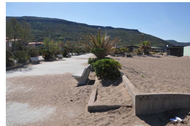
Figura 6 Settore retrodunale, interessato da infrastrutture per la fruizione balneare (accessi e servizi turistico-ricreativi) in cui si evidenziano gli accumuli di sabbia mobilizzata dal vento.
