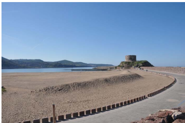
Figura 4 Strada carrabile di accesso alla torre costiera che costeggia il settore settentrionale della spiaggia.
