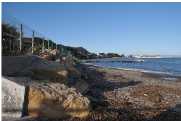
Figura 4 Vista del settore orientale della spiaggia di Perd'e Sali con particolare della massicciata posta a protezione delle strutture antiche localizzate in ambito di spiaggia.
