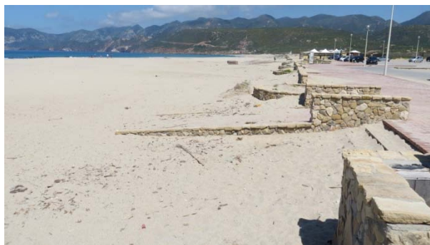
Figura 5 Settore della spiaggia interessato dalla presenza dell'area sosta e servizi delimitati da ; strutture rigide che costituiscono elementi di irrigidimento del sistema e di interferenza con le naturali dinamiche evolutive.
