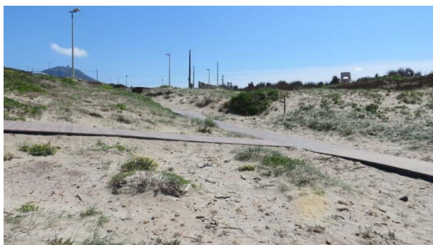
Figura 7 Sistemi di accesso alla spiaggia su passerelle aderenti al piano di campagna che costituiscono elementi di frammentazione e interferenza sull'evoluzione morfologica naturale del sistema dunale.
