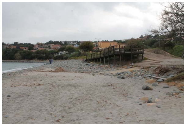
Figura 5 Vista del settore meridionale della spiaggia di Porto Frailis con in evidenza la scalinata di accesso alla spiaggia, accompagnata dalla passerella lignea per l'accesso dei disabili.
