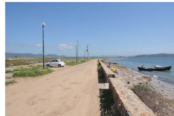
Figura 6 Vista del settore meridionale della spiaggia in cui si evidenzia la presenza della strada carrabile sterrata che corre parallela alla spiaggia con i relativi muri di protezione che costituiscono elementi di irrigidimento del sistema e di interferenza sui naturali processi evolutivi del litorale.
