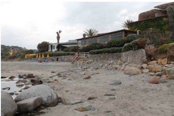
Figura 4 Particolare della spiaggia di Porto Frailis da cui si evince la presenza nel corpo della spiaggia di elementi rigidi quali i-con muri di sostegno realizzati a protezione della scarpata e delle strutture turistico-ricettive realizzate-presenti nel retrospiaggia.
