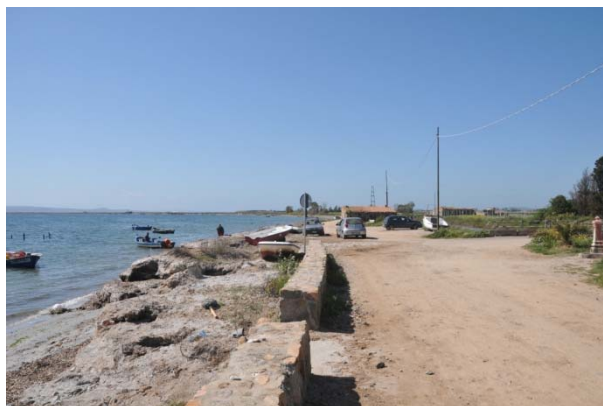
Figura 5 Vista del settore settentrionale della spiaggia in cui si evidenzia la presenza di elementi antropici, quali edifici, infrastrutture stradali-viarie e aree sosta, che determinano un con irrigidimento del sistema con ed interferenze sui naturali processi evolutivi del litorale.
