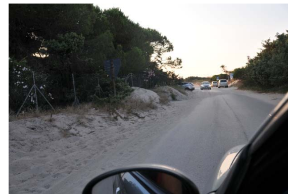
Figura 6 Viabilità carrabile di accesso al litorale realizzata all'interno del compendio dunale stabilizzato.
