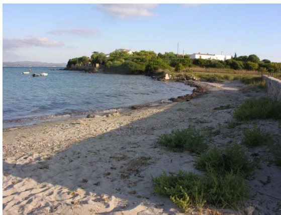
Figura 4 Evidenze di arretramento della linea di riva in corrispondenza di strutture rigide (muri ed abitazioni).
