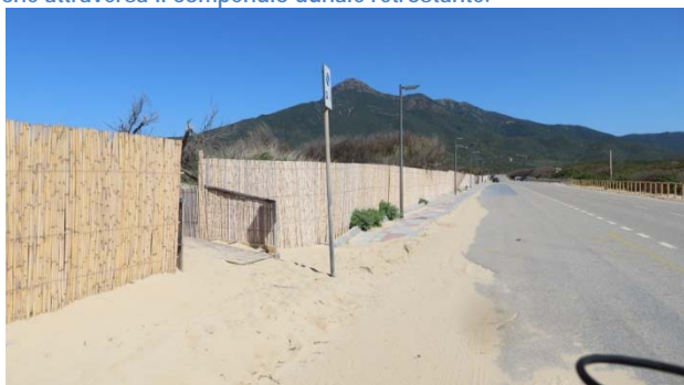
Figura 7 Processi di insabbiamento dell'infrastruttura stradale e delle relative aree di sosta ad opera del trasporto eolico che risulta limitato solo in parte dal posizionamento degli schermi frangivento.
