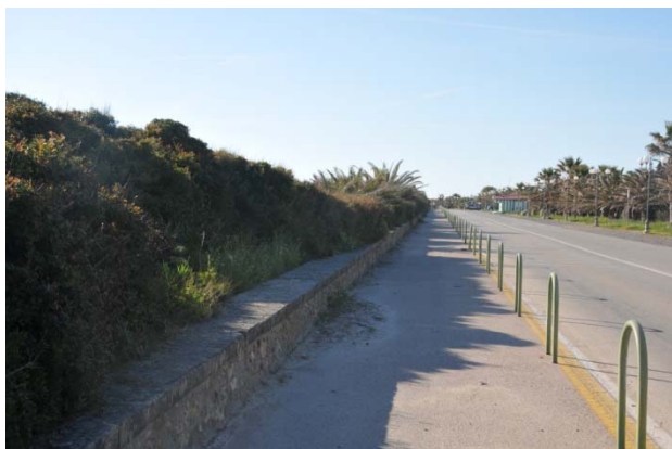
Figura 4 Strada provinciale, con pista ciclabile, aree sosta e muri di contenimento laterali, che si sviluppate all'interno del settore dunale stabilizzato, parallelamente alla linea di costa.
