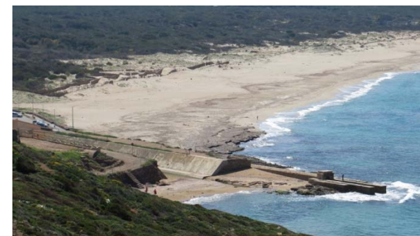
Figura 9 Vista del settore settentrionale della spiaggia, interessato dalla presenza del canale di scarico delle acque provenienti dalla palude di Sa Masa.
