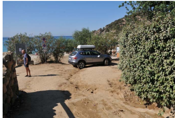
Figura 5 Area sosta localizzata in ambito di retrospiaggia, interessata da processi erosivi diffusi e incanalati ad opera delle acque di ruscellamento superficiale libere non canalizzate.
