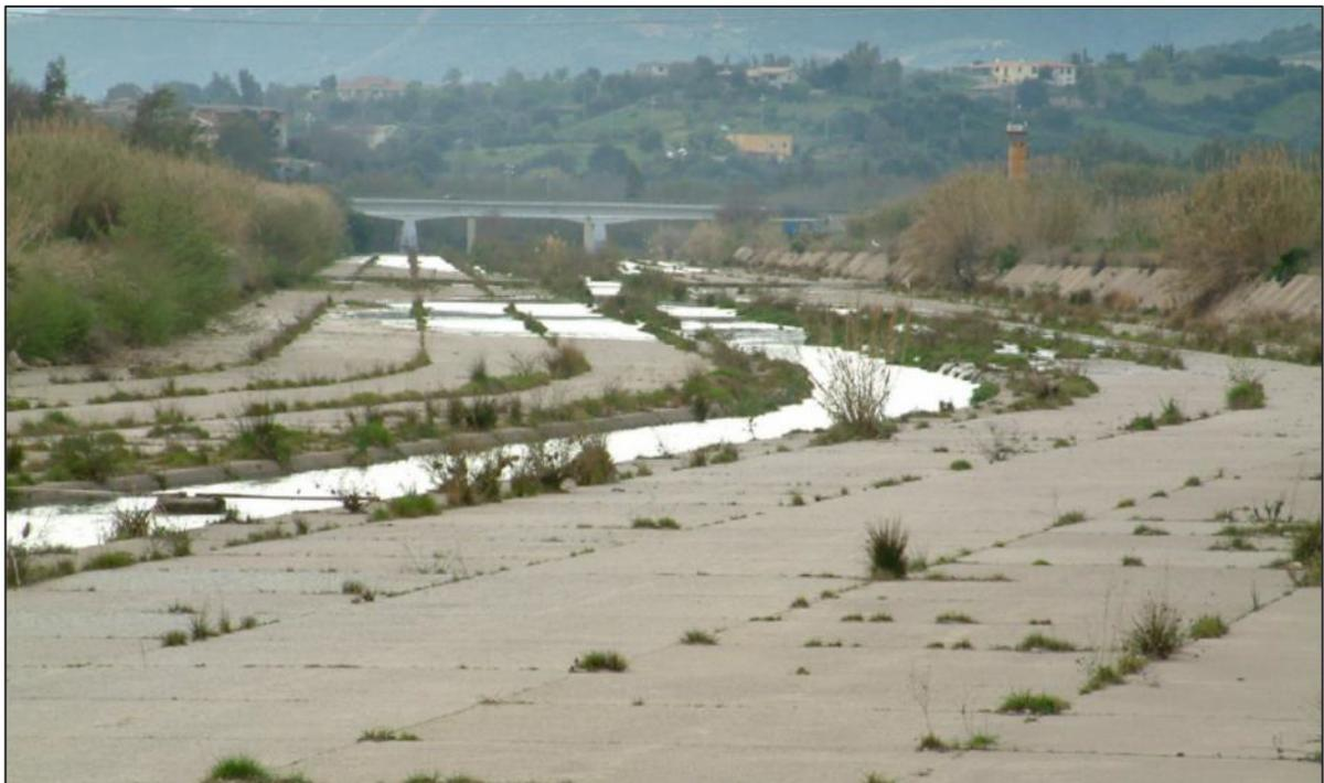
Figura 6.4 – Canalizzazione trapezia in calcestruzzo con savanella a valle della SS 125 (fonte PSFF)
