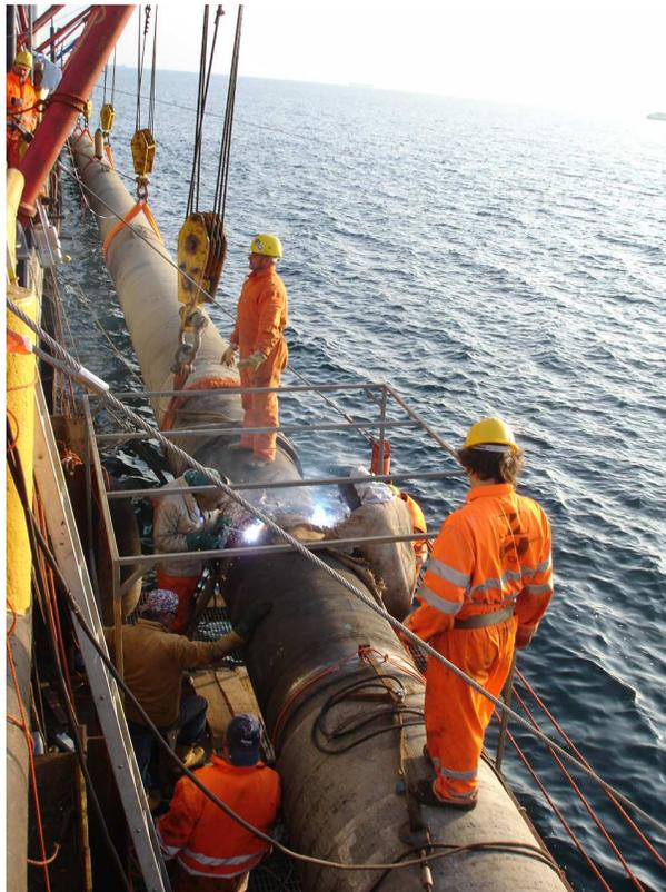
**Fig. 5.7 - Saldatura di Tie-in**
