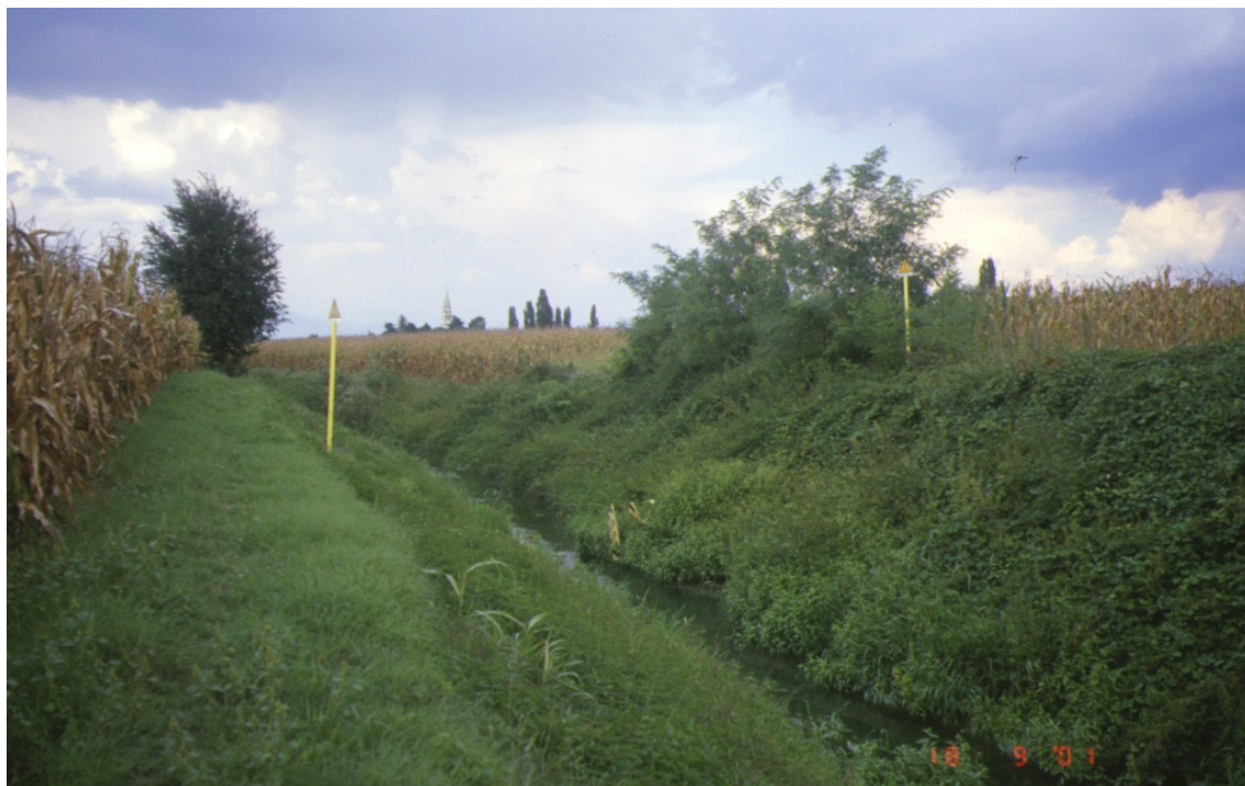
Foto 9/D: Attraversamento canale irriguo
