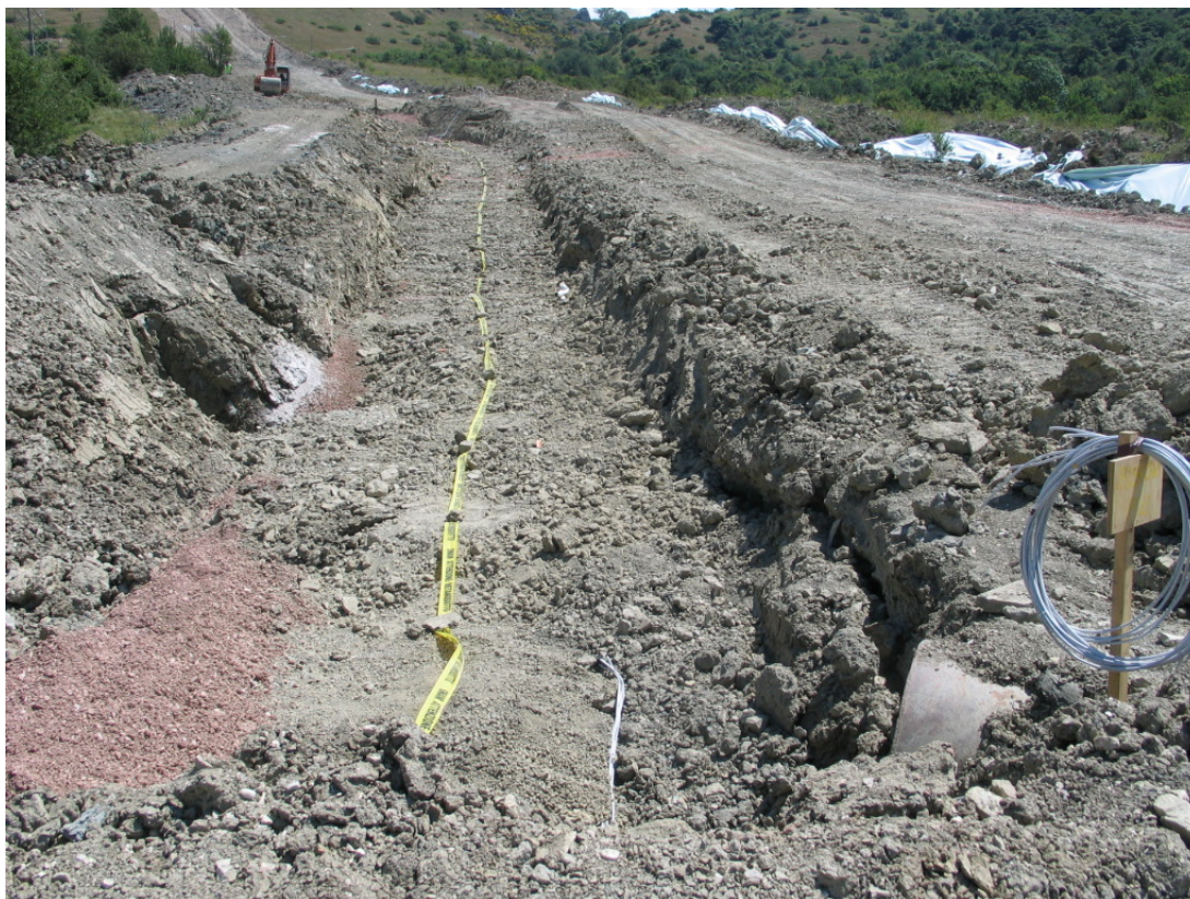
Foto 5.1/H: Rinterro della condotta
