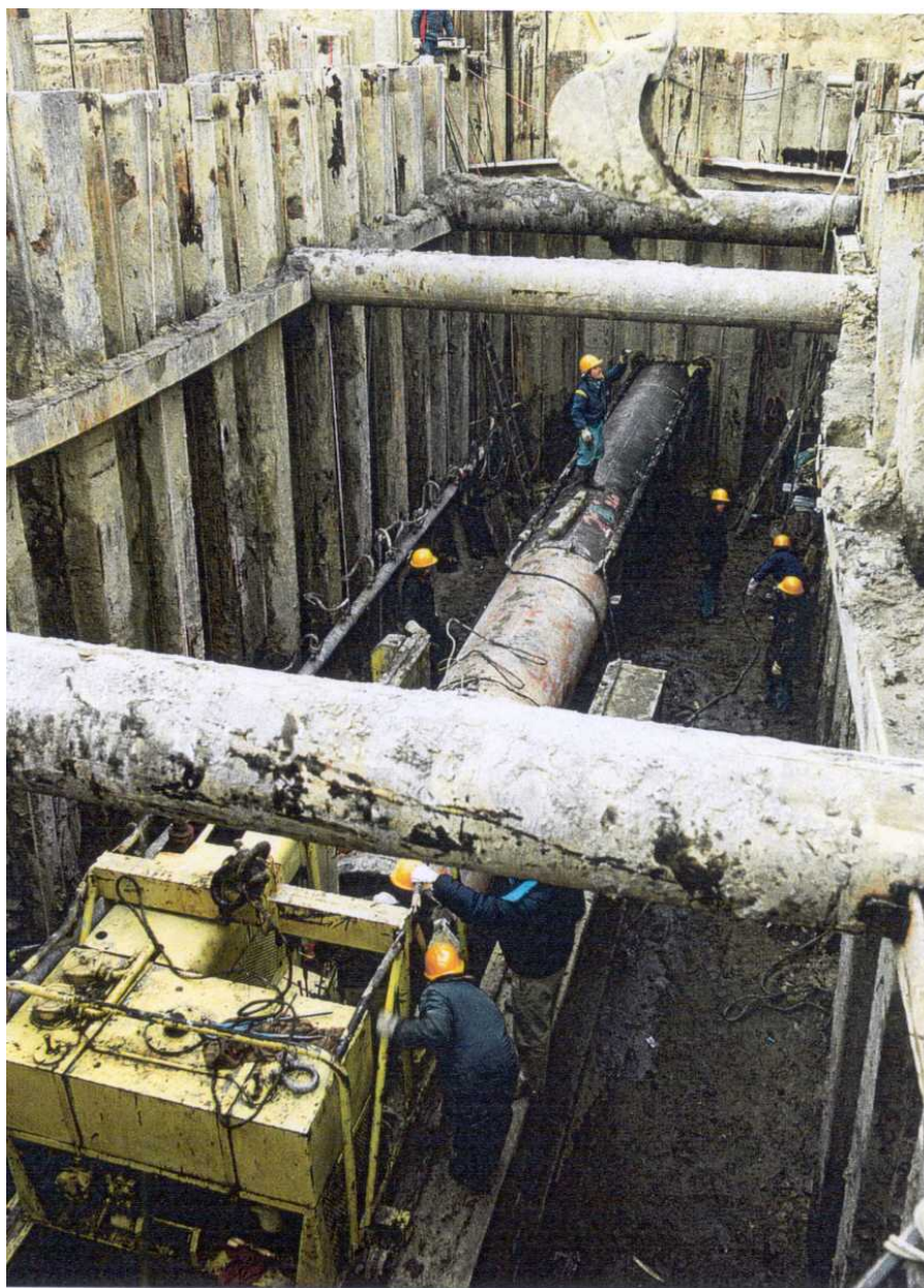
Foto 5.1/L: Trivellazione con spingitubo
