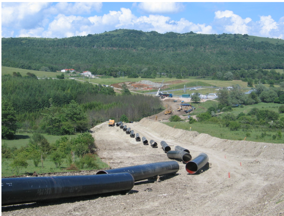
Foto 5.1/C: Sfilamento tubazioni
