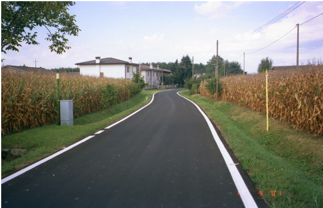
Foto 9/C: Attraversamento strada comunale
