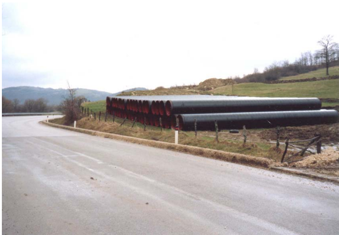
Foto 5.1/A: Piazzola di accatastamento tubazioni
