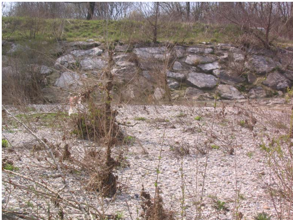
Foto 2.3/C – Difesa sponale del Torre (sponda sinistra) in prossimità dell'attraversamento
