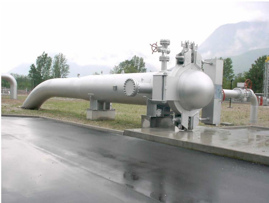
Foto 4.2/A: Punto di lancio e ricevimento pig
