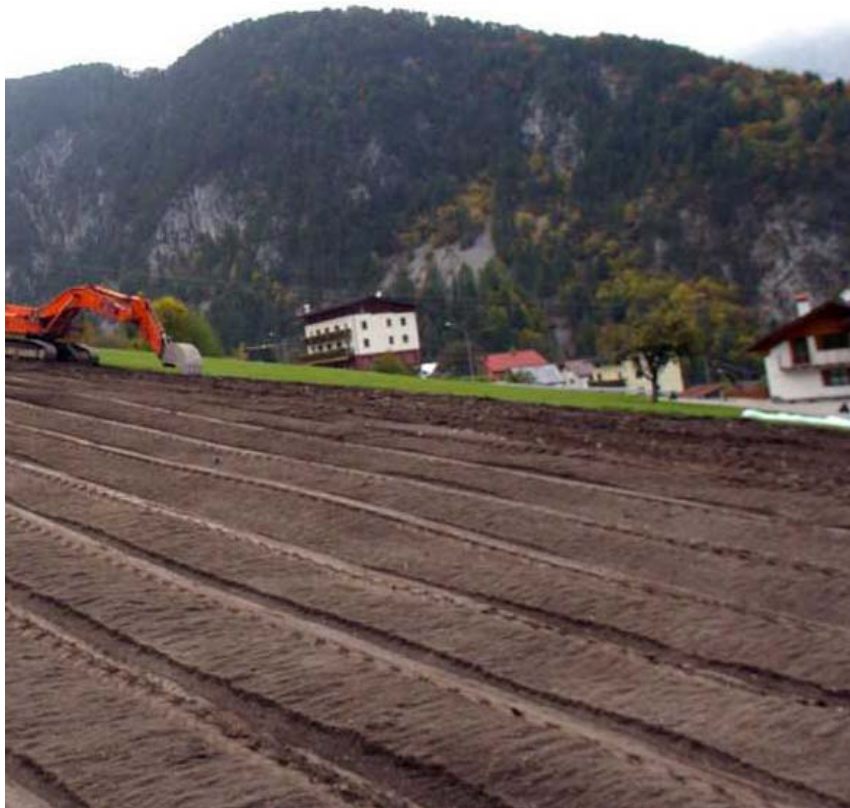
Foto 5.1/I: Ridistribuzione dello strato humico superficiale
