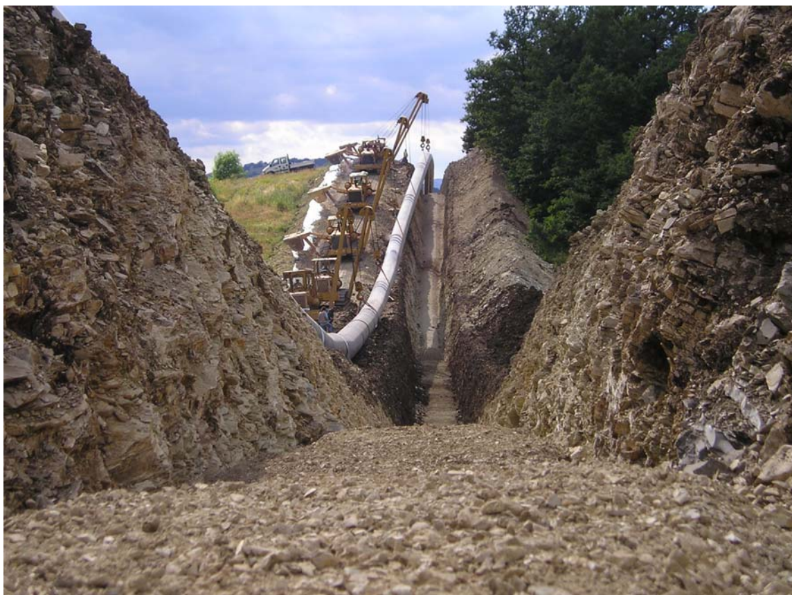
Foto 5.1/F: Posa della condotta
