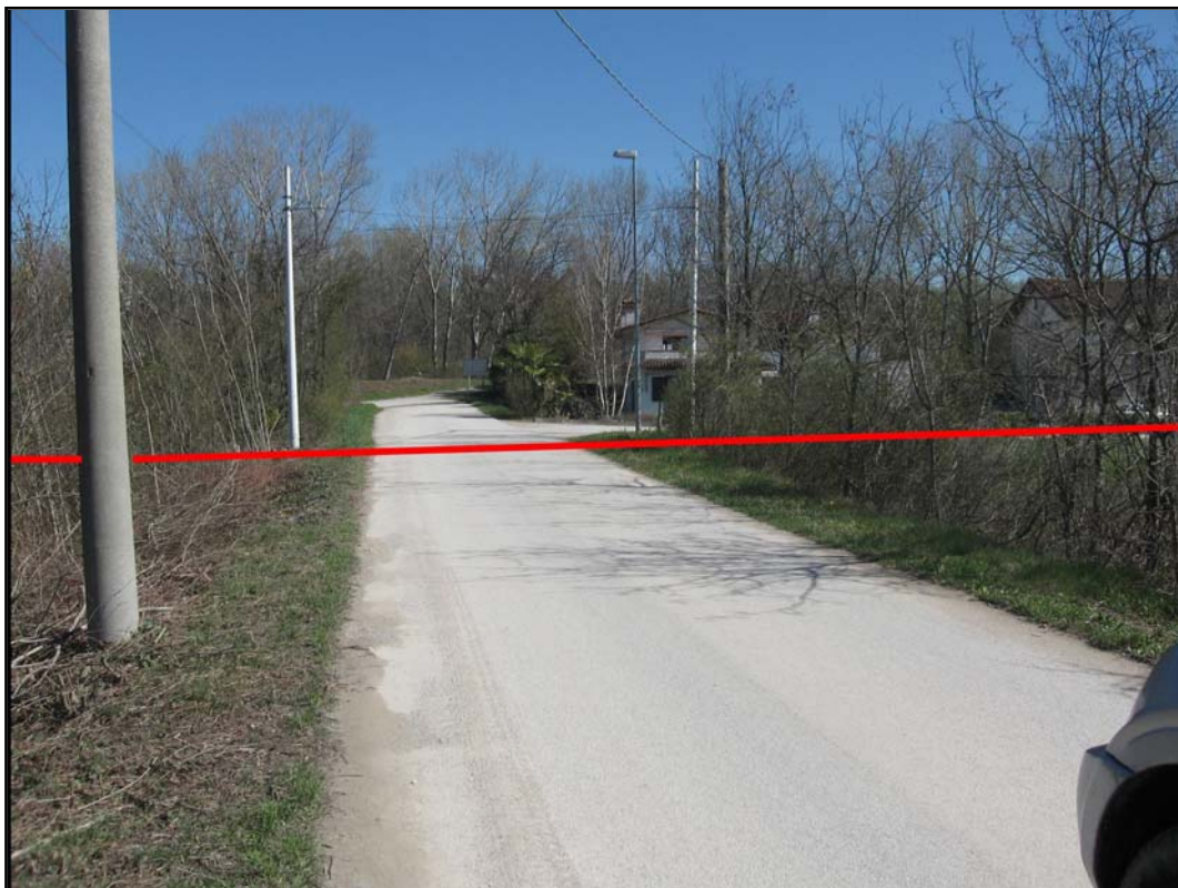
Foto 13: Attraversamento strada comunale via Isonzo, Comune di Fiumicello
