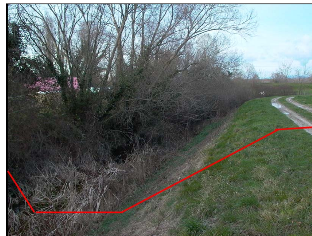
Foto 8: Attraversamento Canale Renzita, Comune di S. Canzian d'Isonzo
