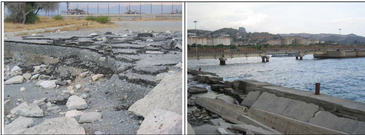
Stato di fatto delle le strutture portuali (fotografie riprese nel settembre 2007)
