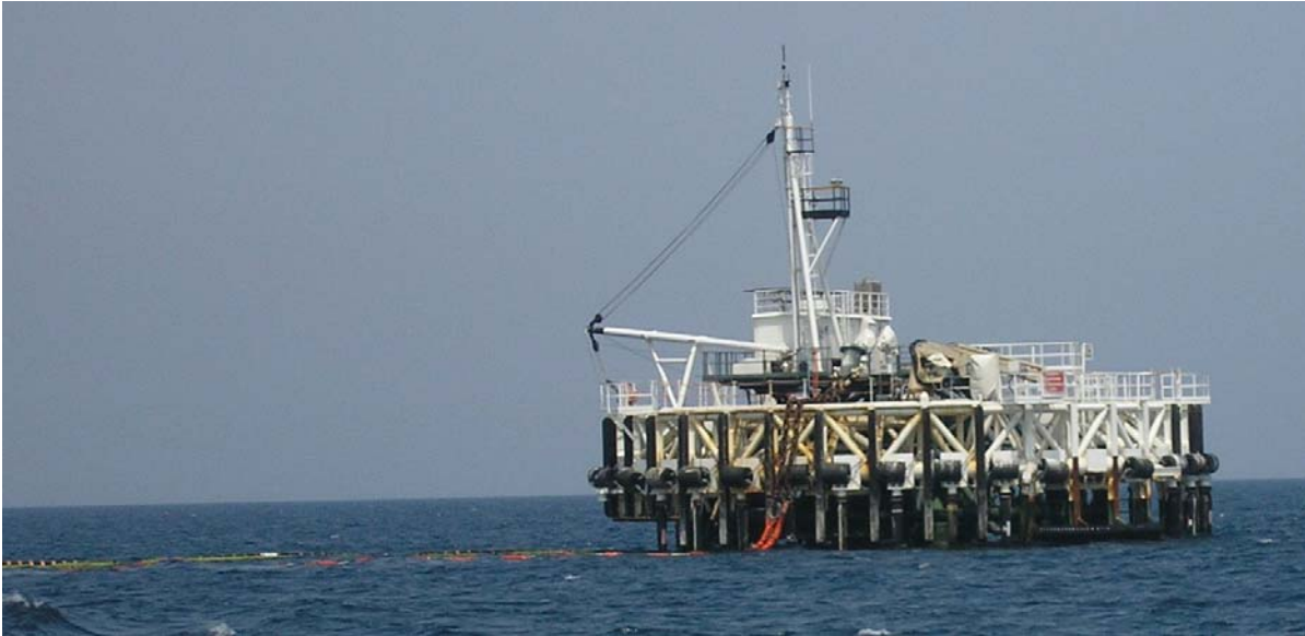
Figura 2 - Attuale piattaforma SPM (Single Point Mooring) operativa al largo di Falconara Marittima.
